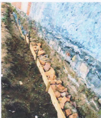
ESCAVAÇÃO DE VALA -10.673319, -37.426189
