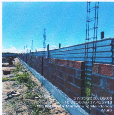
MURO EM ALVENARIA DE BLOCO -10.673658, -37.425769
