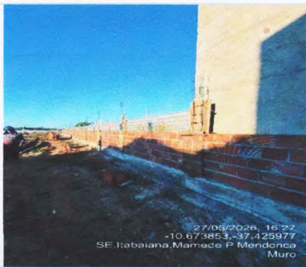
MURO EM ALVENARIA DE BLOCO -10.673819, -37.425997
