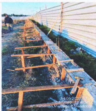
LOCAÇÃO DE MURO (Coordenadas, comentários, etc.)
