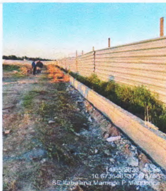
LOCAÇÃO DE MURO / CINTAMENTO INFERIOR (Coordenadas, comentários, etc.)
