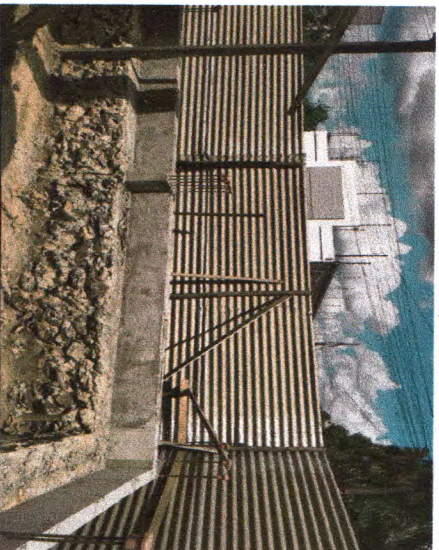
ESCAVAÇÃO: CONCRETO ARMADO SAPATAS E ARRANQUES DOS PILARES; TAPUME METÁLICO
