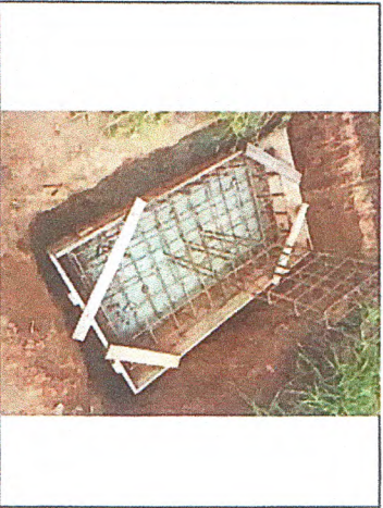
ESCAVAÇÃO MANUAL DE VALA, CONCRETO MAGRO, FORMA DE MADEIRA PARA FUNDAÇÃO, FERRAGEM DA SAPATA E ARRANQUE DO PILAR
