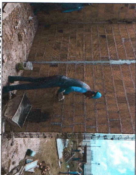
EXECUÇÃO DO ABRIGO DOS RESERVATÓRIOS PARA IRRIGAÇÃO
