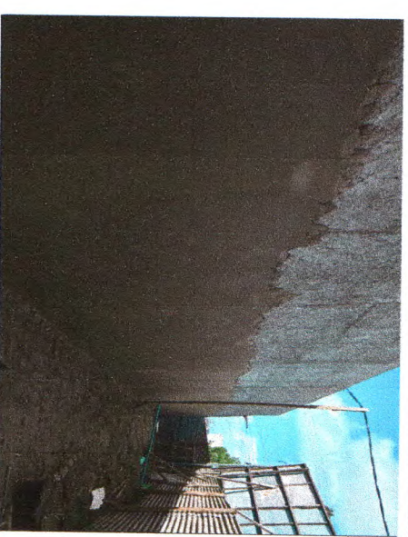
MURO EM ALVENARIA DE BLOCO CERÂMICO; CHAPISCO E REBOCO
