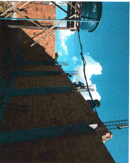
CONCRETO ARMADO PILARES E CINTA INFERIOR; ALVENARIA DE PEDRA E BLOCO CERÂMICO
