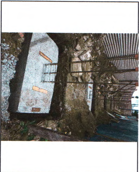
ESCAVAÇÃO: CONCRETO ARMADO SAPATAS E ARRANQUES DOS PILARES; TAPUME METÁLICO
