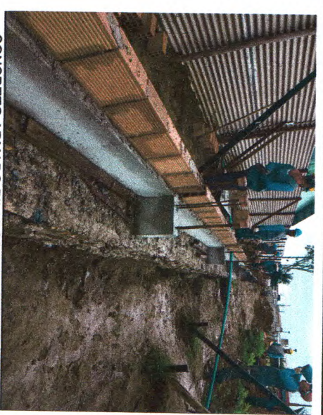
CONCRETO ARMADO PILARES E CINTA INFERIOR; ALVENARIA DE PEDRA E BLOCO CERÂMICO
