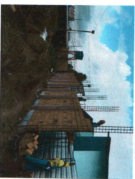
CONCRETO ARMADO PILARES E CINTA INFERIOR; ALVENARIA DE PEDRA E BLOCO CERÂMICO
