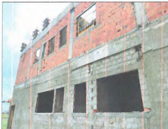
VERGA, CONTRAVERGA, CHAPISCO E ALVENARIA DE VEDAÇÃO
