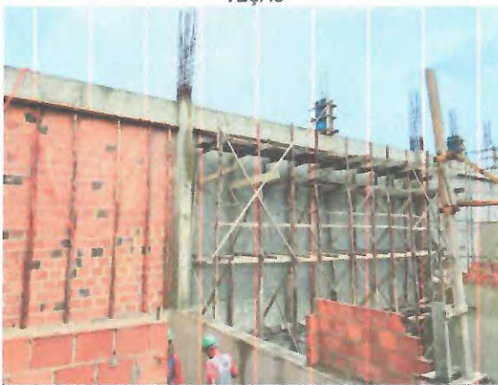
CHAPISCO E ALVENARIA DE VEDAÇÃO
