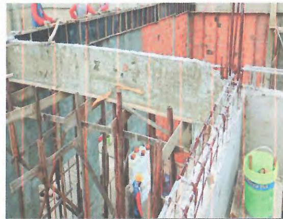
CHAPISCO E ALVENARIA DE VEDAÇÃO
