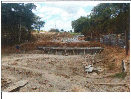
CONCRETO CICLÓPICO - BASE DA PONTE
