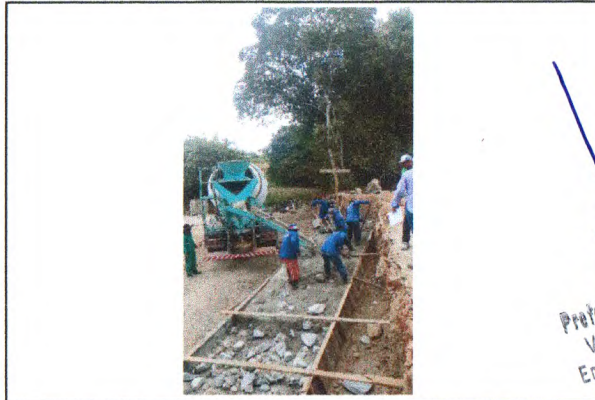
CONCRETO CICLÓPICO - BASE DA PONTE
