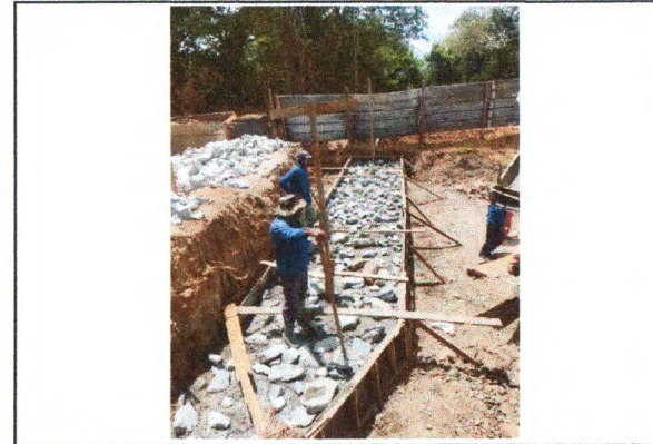
CONCRETO CICLÓPICO - BASE DA PONTE
