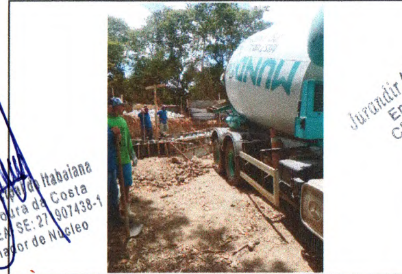
CONCRETO CICLÓPICO - BASE DA PONTE
