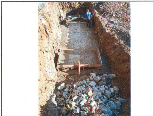
CONCRETO CICLÓPICO - BASE DA PONTE
