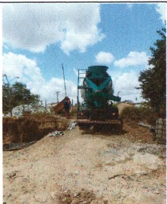
CONCRETO CICLÓPICO - BASE DA PONTE
