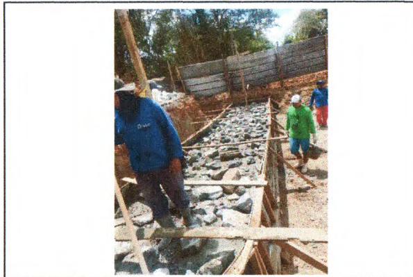
CONCRETO CICLÓPICO - BASE DA PONTE
