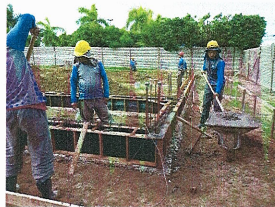
FORMAS E CONCRETAGEM DAS VIGAS BALDRAMES
