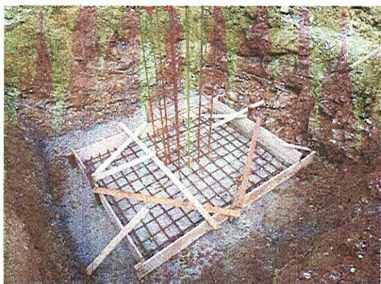
ESCAVAÇÃO MANUAL; CONCRETO MAGRO; FORMA DE MADEIRA; FERRAGEM DA SAPATA E ARRANQUE DO PILAR
