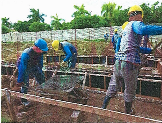
FORMAS E CONCRETAGEM DAS VIGAS BALDRAMES
