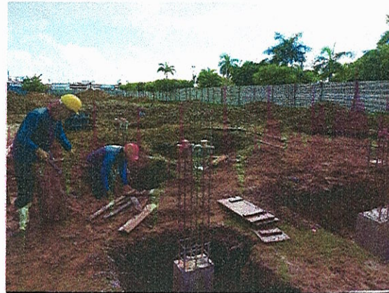
ESCAVAÇÃO MANUAL; SAPATAS E ARRANQUES DOS PILARES
