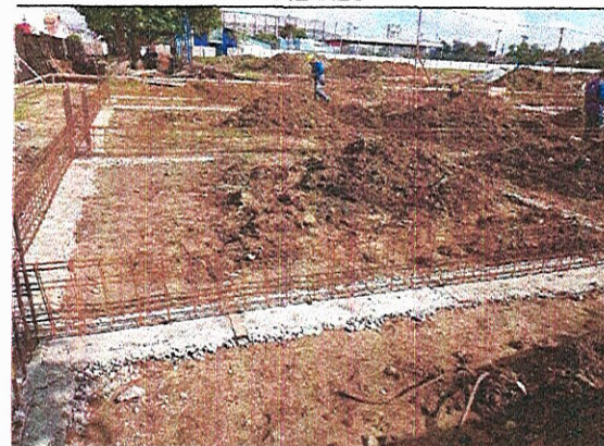
REATERRO; FERRAGEM DOS ARRANQUES DOS PILARES E VIGAS BALDRAMES
