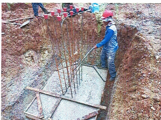
CONCRETAGEM DA SAPATA
