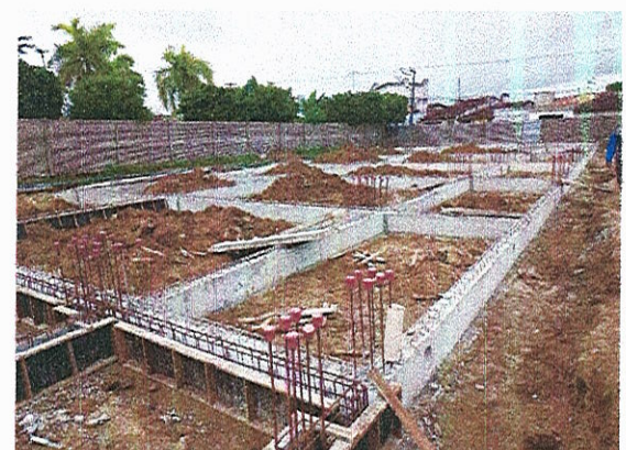
FORMAS, FERRAGENS E CONCRETO DAS VIGAS BALDRAMES
