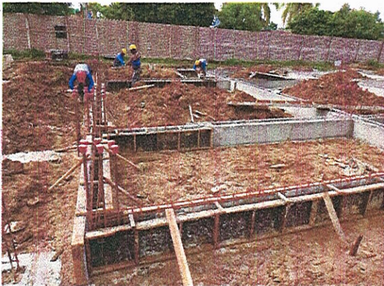
FORMAS, FERRAGENS E CONCRETO DAS VIGAS BALDRAMES
