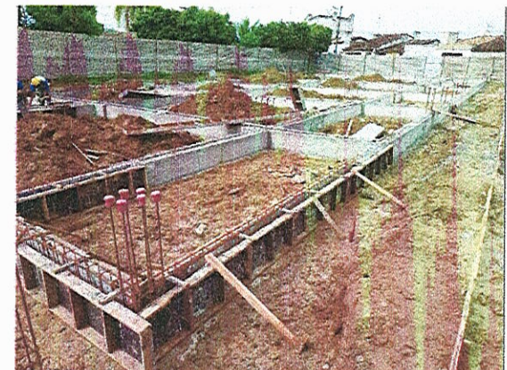
FORMAS E CONCRETO DAS VIGAS BALDRAMES
