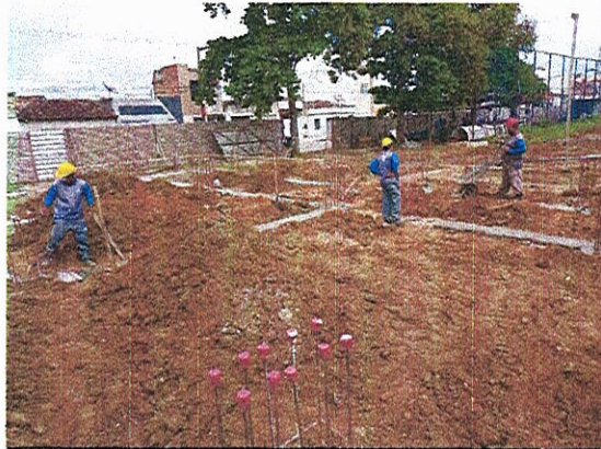
REATERRO; FERRAGEM DOS ARRANQUES DOS PILARES
