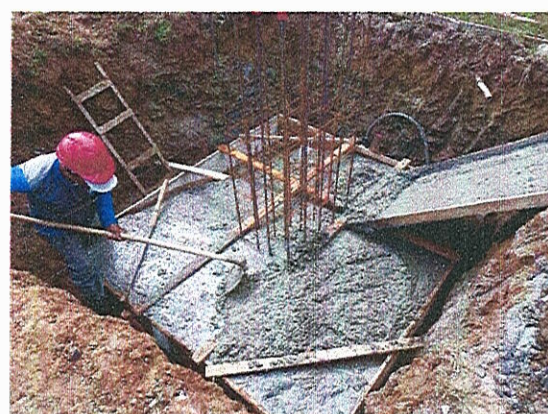
ESCAVAÇÃO; CONCRETAGEM DA SAPATA
