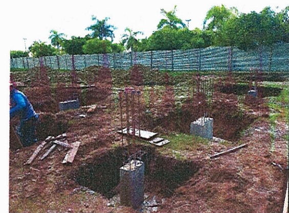
ESCAVAÇÃO MANUAL; SAPATAS E ARRANQUES DOS PILARES
