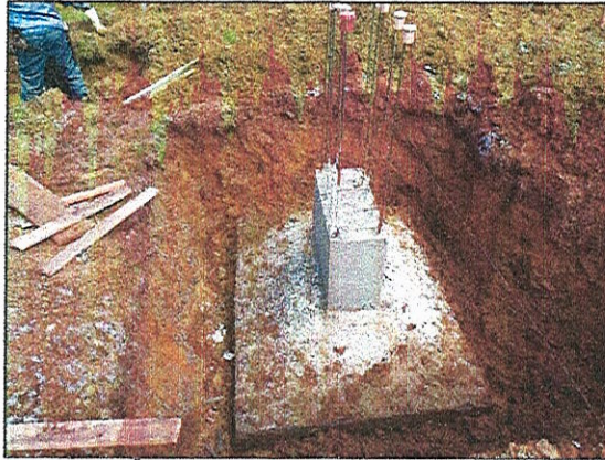
ESCAVAÇÃO MANUAL; SAPATAS E ARRANQUES DOS PILARES
