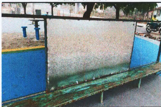
REVISÃO EM ESTRUTURA METÁLICA
