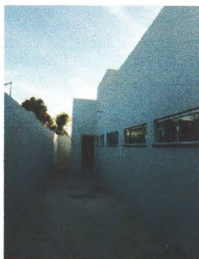
PINTURA DE PAREDE
