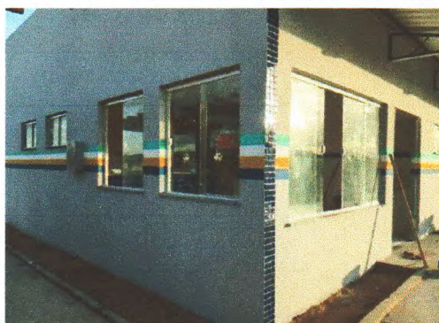
PINTURA DE PAREDE
