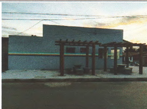
CONCRETAGEM DA CALÇADA
