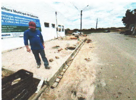
ATERRO E COMPACTAÇÃO
