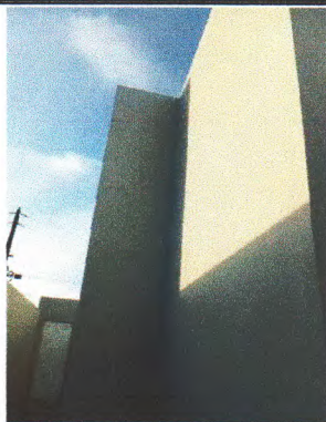
PINTURA DE PAREDE
