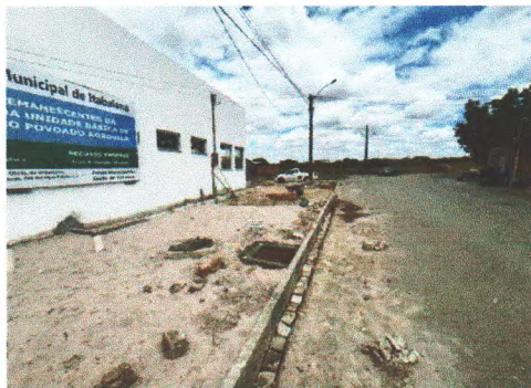
ATERRO E COMPACTAÇÃO
