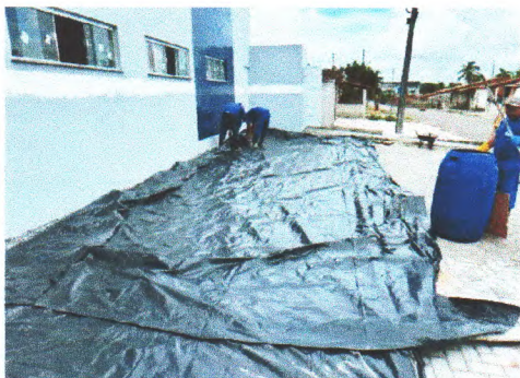
INSTALAÇÃO DE LONA
