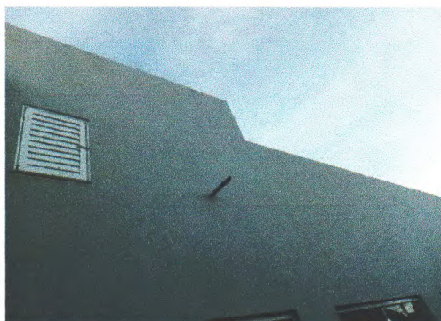
PINTURA DE PAREDE
