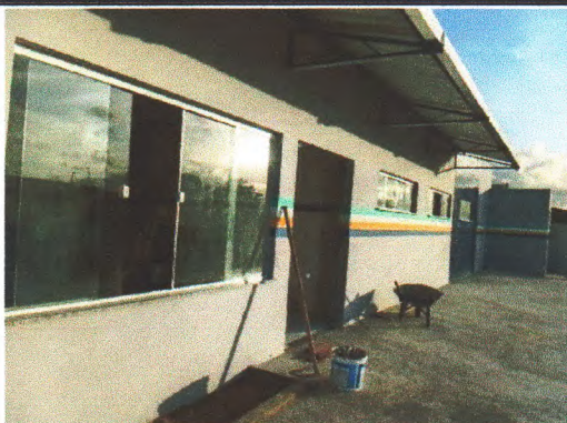
PINTURA DE PAREDE
