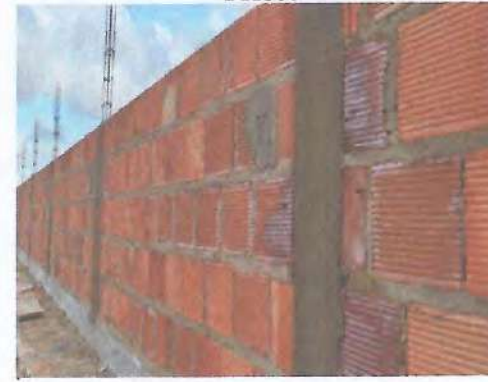
EXECUÇÃO ALVENARIA DE BLOCO
