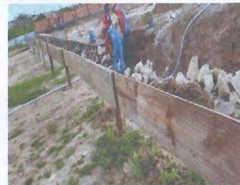
LOCAÇÃO DE OBRA - EXECUÇÃO ALVENARIA DE PEDRA E BLOCO
