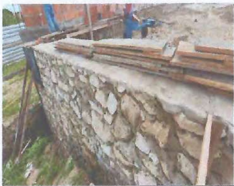
EXECUÇÃO ALVENARIA DE PEDRA
