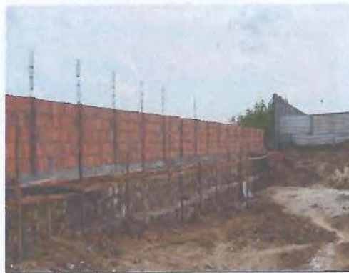
EXECUÇÃO ALVENARIA DE PEDRA E BLOCO
