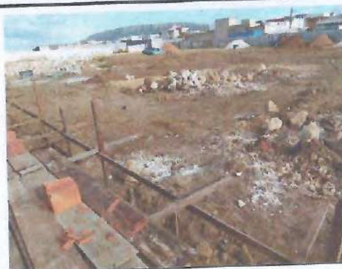
GABARITO - LOCAÇÃO DE OBRA
