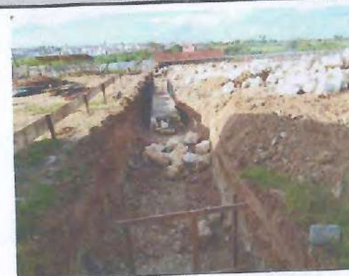
LOCAÇÃO DE OBRA - ALVENARIA DE PEDRA
