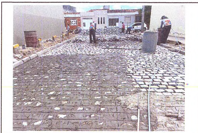
ASSENTAMENTO DE MEIO-FIO, PAVIMENTAÇÃO E DRENAGEM SUPERFICIAL - MARIA VALDETE ARAUJO SANTOS
