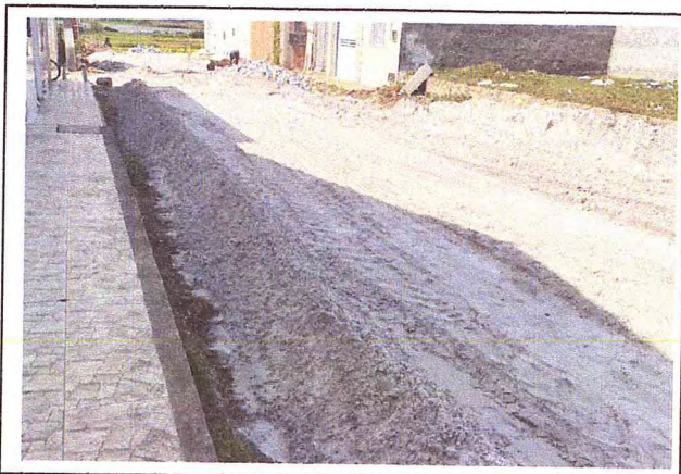
REGULARIZAÇÃO, COLCHÃO DE AREIA - PROLONGAMENTO DA RUA JOSÉ SIZINIO DE ALMEIDA
