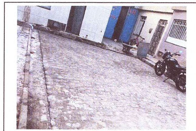
ASSENTAMENTO DE MEIO-FIO, DRENAGEM SUPERFICIAL E PAVIMENTAÇÃO - RUA JOSÉ PAULO VIEIRA
