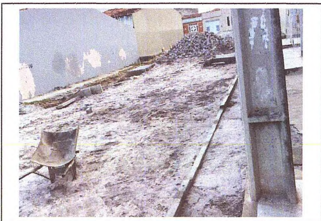
REGULARIZAÇÃO, ASSENTAMENTO DE MEIO-FIO, COLÇÃO DE AREIA - RUA MARIA VALDETE ARAUJO SANTOS
