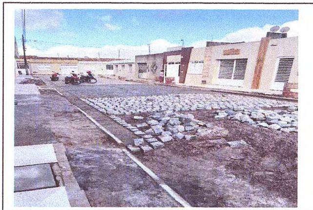
REGULARIZAÇÃO, ASSENTAMENTO DE MEIO-FIO, COLÇÃO DE AREIA DRENAGEM SUPERFICIAL E PAVIMENTAÇÃO - RUA JOSÉ PAULO VIEIRA
