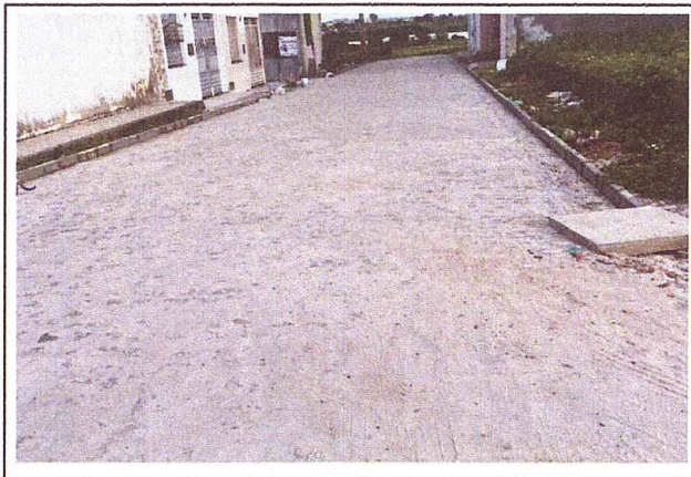
ASSENTAMENTO DE MEIO-FIO, DRENAGEM SUPERFICIAL, PAVIMENTAÇÃO - PROLONGAMENTO DA RUA JOSÉ SIZÍNIO DE ALMEIDA
