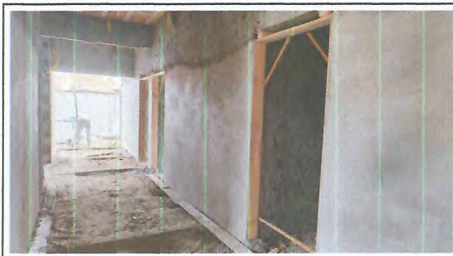
CHAPISCO E REBOCO INTERNO
