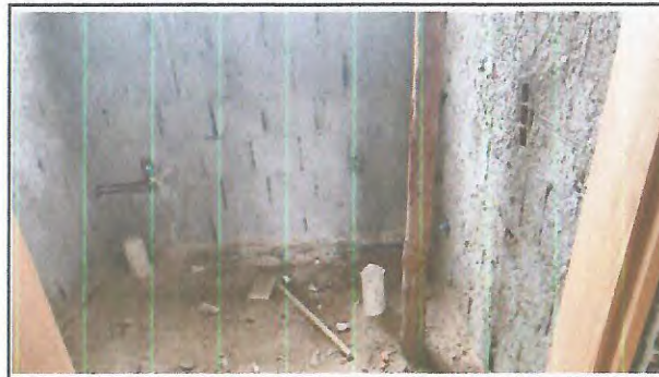
CHAPISCO E INSTALAÇÃO HIDRÁULICA
