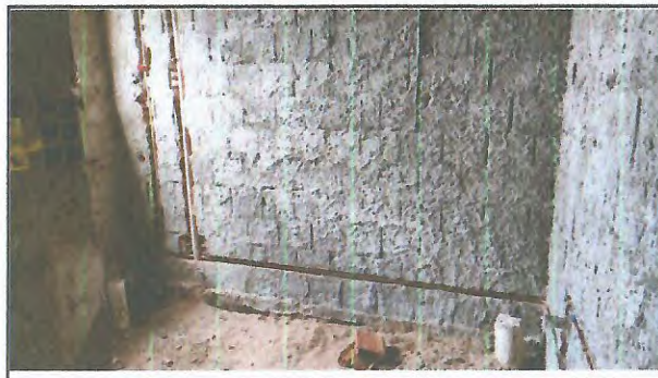
CHAPISCO E INSTALAÇÃO HIDRÁULICA
