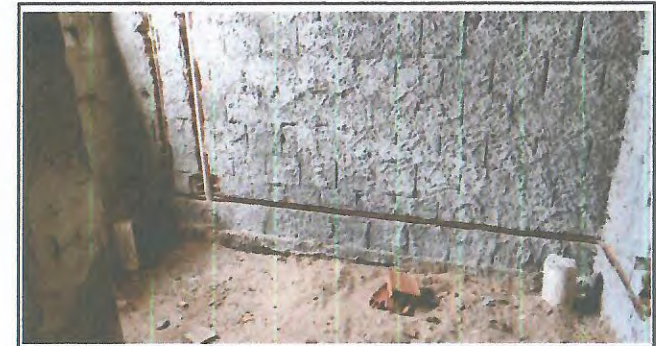
CHAPISCO, INSTALAÇÃO HIDRÁULICA E ELÉTRICAS
