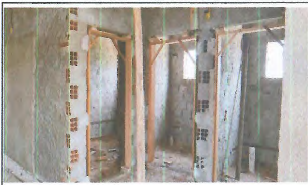
CHAPISCO E REBOCO INTERNO
