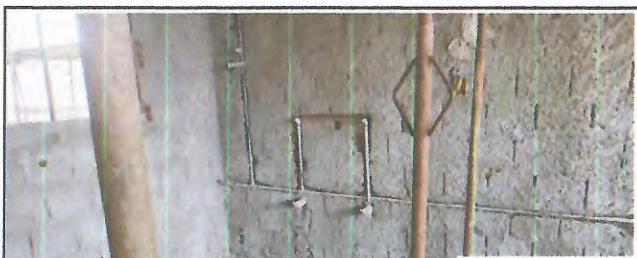
INSTALAÇÕES HIDRAULICAS, CHAPISCO, E ESCORAMENTO
