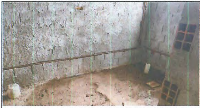
CHAPISCO E INSTALAÇÃO HIDRÁULICA
