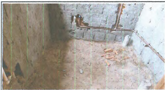
CHAPISCO E INSTALAÇÃO HIDRÁULICA
