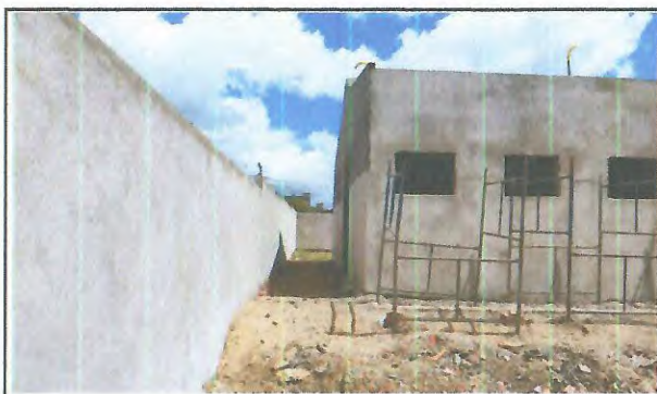
MURO E REBOCO EXTERNO
