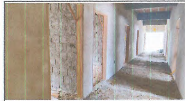
CHAPISCO E EXECUÇÃO DA LAJE
