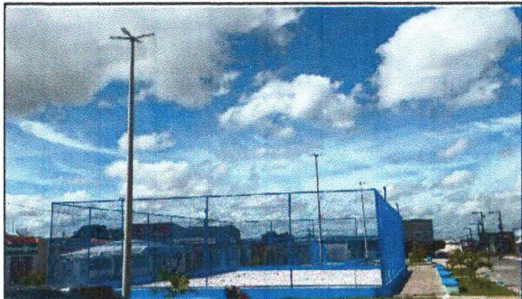
INSTALAÇÕES ELETRICA - LUMINÁRIAS
