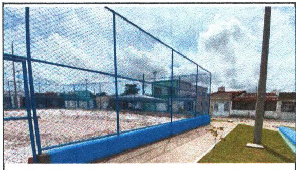
PINTURA DOS PORTÕES, CAIXA DE PASSAGEM ELÉTRICA
