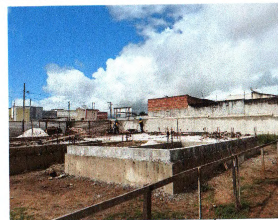
VIGA BALDRAME E PINTURA ASFÁLTICA
