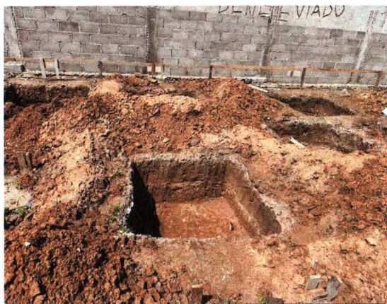
ESCAVAÇÃO E MURO EM BLOCO DE CIMENTO
