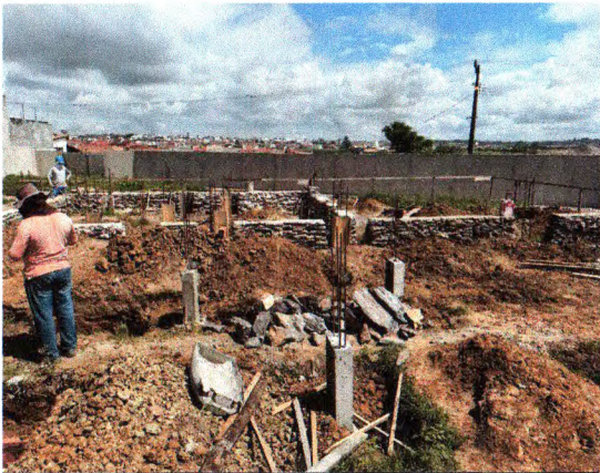
ALVENARIA DE PEDRA
