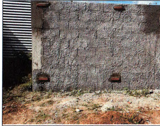
CHAPISCO EM MURO
