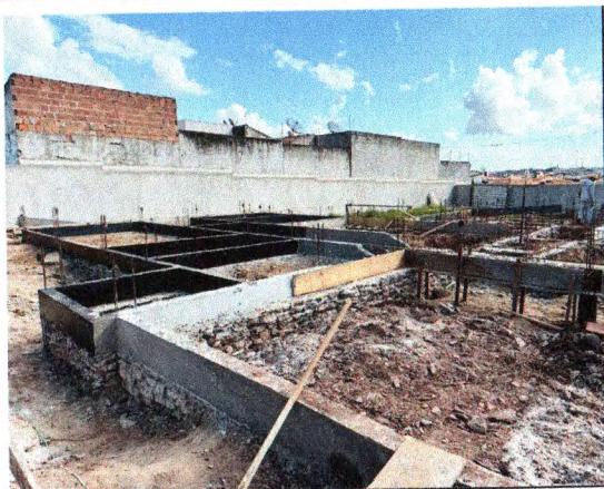
VIGA BALDRAME E PINTURA ASFÁLTICA
