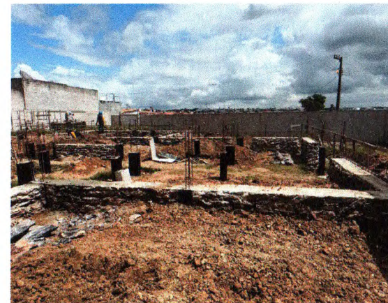
ALVENARIA DE PEDRA E ARRANQUES
