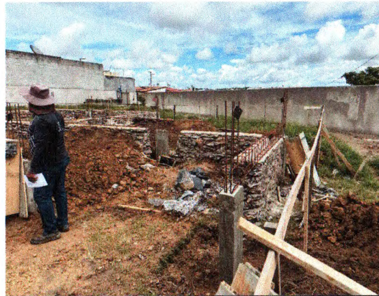
ALVENARIA DE PEDRA E ARRANQUES
