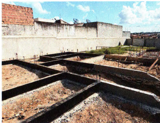
VIGA BALDRAME E PINTURA ASFALTICA
