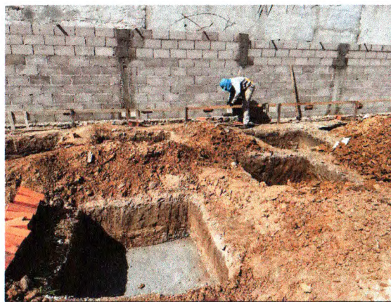
ESCAVAÇÃO, MURO EM BLOCO DE CIMENTO E CONCRETO MAGRO
