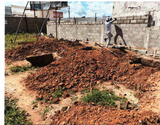
ESCAVAÇÃO E MURO EM BLOCO DE CIMENTO
