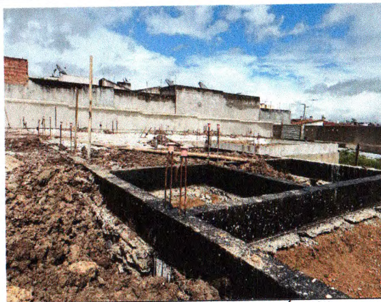
VIGA BALDRAME E PINTURA ASFÁLTICA
