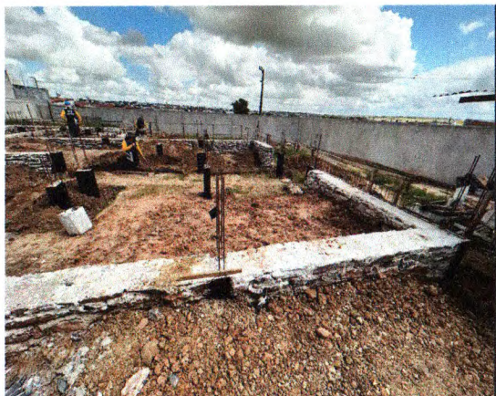
ALVENARIA DE PEDRA E PINTURA ASFALTICA
