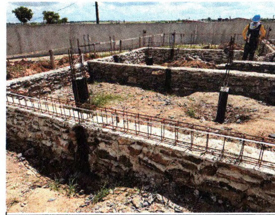
ALVENARIA DE PEDRA, VIGA BALDRAME E PINTURA ASFALTICA
