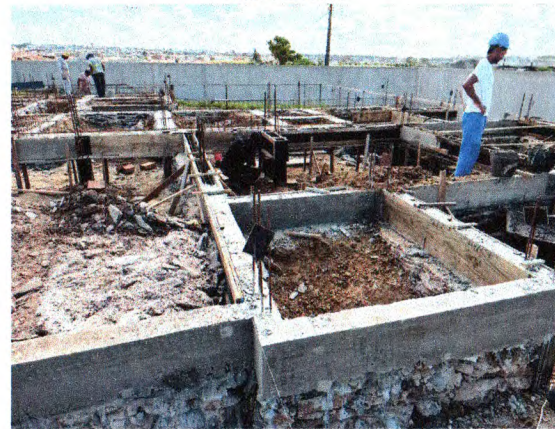
VIGA BALDRAME E PINTURA ASFALTICA
