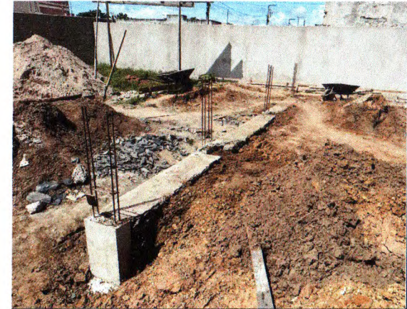
ALV DE PEDRA, ARRANQUES E MURO REBOCADO
