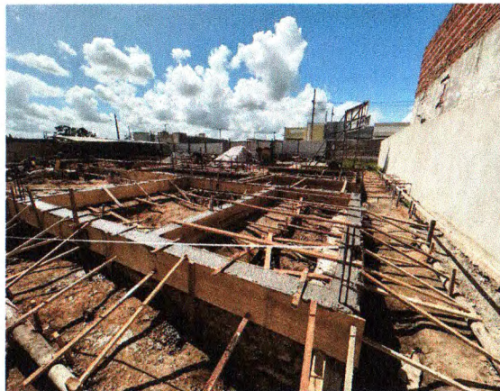
ALVENARIA DE PEDRA E VIGA BALDRAME
