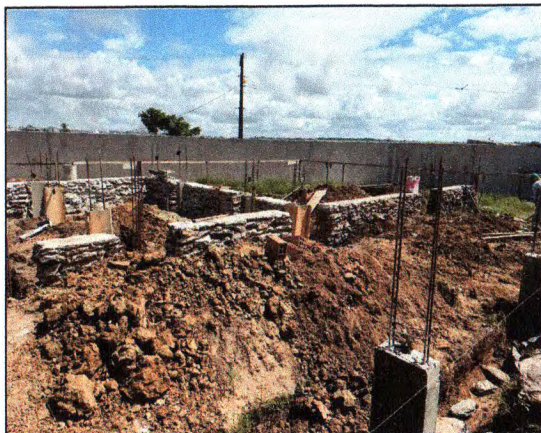
ALVENARIA DE PEDRA E ARRANQUES
