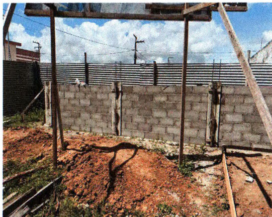
MURO EM BLOCO DE CIMENTO
