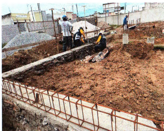
ALVENARIA DE PEDRA E VIGA BALDRAME
