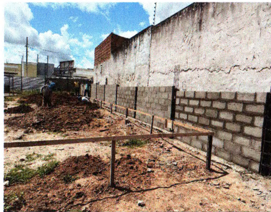
MURO EM BLOCO DE CIMENTO
