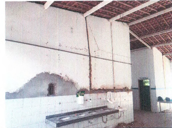
REVISÃO DA COBERTURA EM TELHA CERÂMICA; INSTALAÇÃO ELÉTRICA
