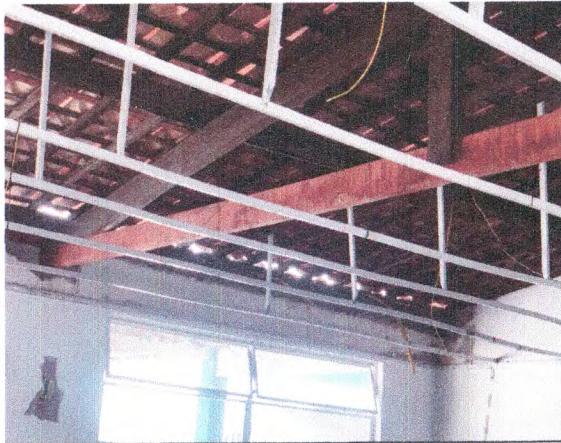
DEMOLIÇÃO DE FORROS DE PVC; REVISÃO DA COBERTURA EM TELHA CERÂMICA; INSTALAÇÃO
