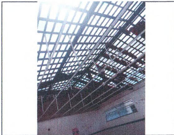
REVISÃO DA COBERTURA EM TELHA CERÂMICA; DEMOLIÇÃO DE FORROS DE PVC
