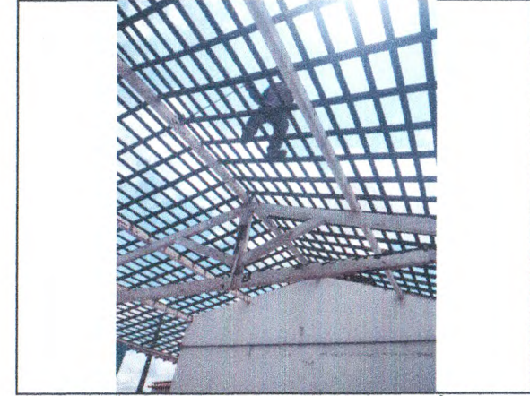
REVISÃO DA COBERTURA EM TELHA CERÂMICA
