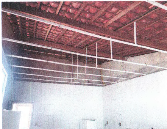
DEMOLIÇÃO DE FORROS DE PVC; REVISÃO DA COBERTURA EM TELHA CERÂMICA; INSTALAÇÃO ELÉTRICA
