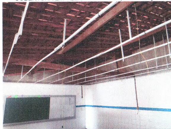
DEMOLIÇÃO DE FORROS DE PVC; REVISÃO DA COBERTURA EM TELHA CERÂMICA; INSTALAÇÃO ELÉTRICA
