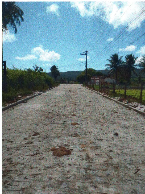
Foto 08: Pavimentação em paralelepípedo granítico sobre colchão de areia.
