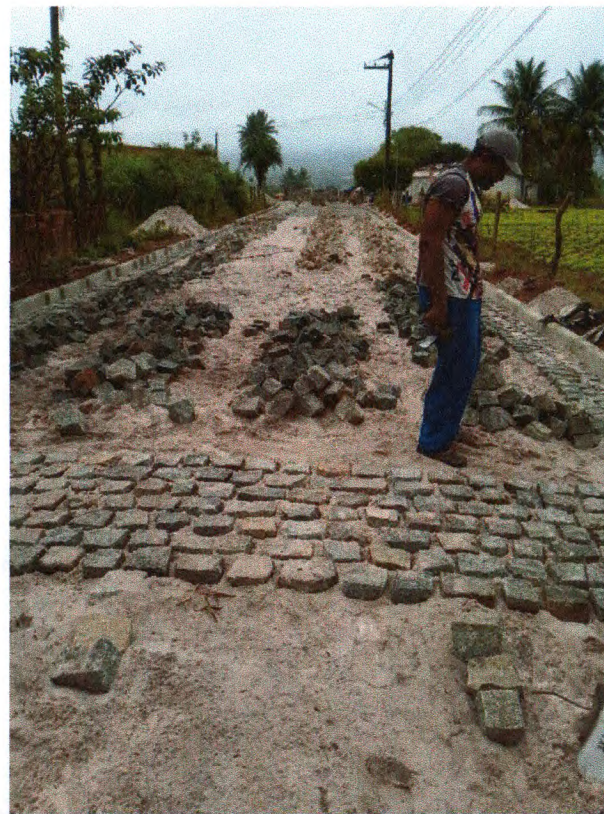
Foto 05: Pavimentação em paralelepípedo granítico sobre colchão de areia.
