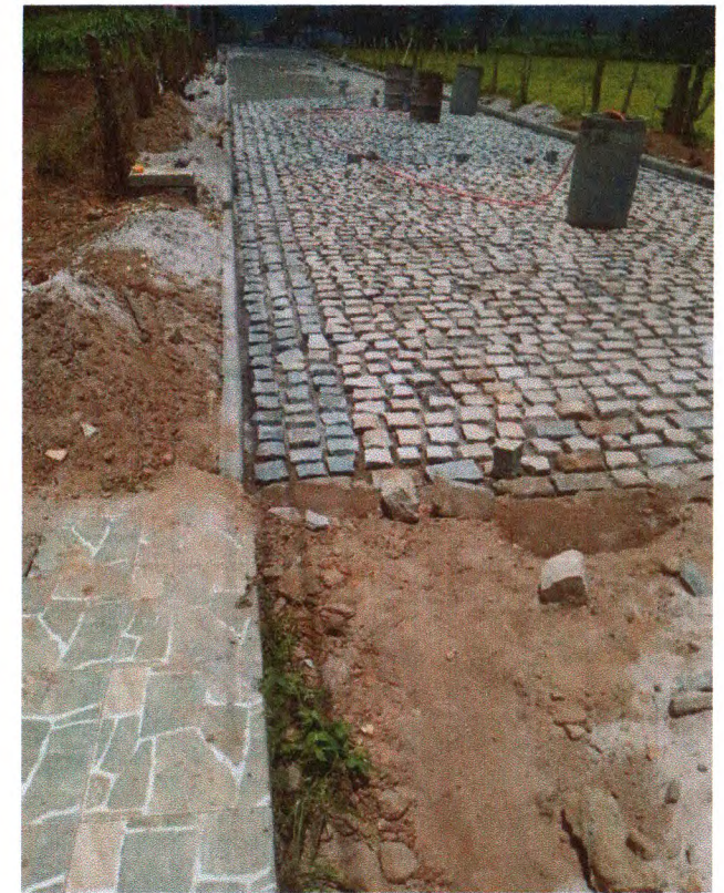
Foto 06: Pavimentação em paralelepípedo granítico sobre colchão de areia.
