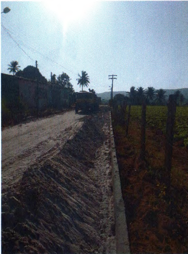
Foto 04: Colchão de areia.
