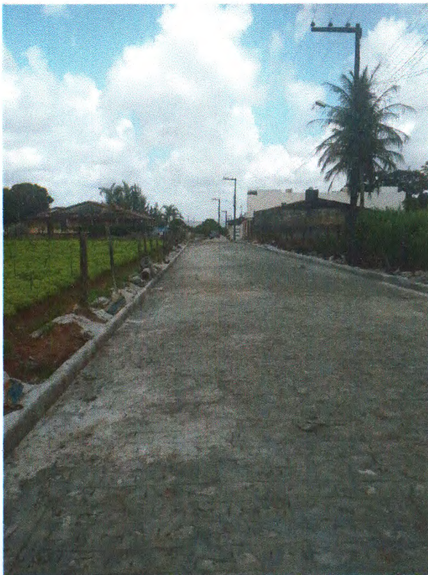
Foto 07: Pavimentação em paralelepípedo granítico sobre colchão de areia.
