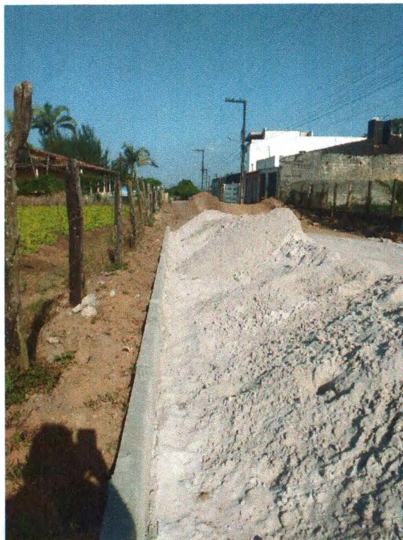
Foto 02: Locação de serviços de pavimentação.
