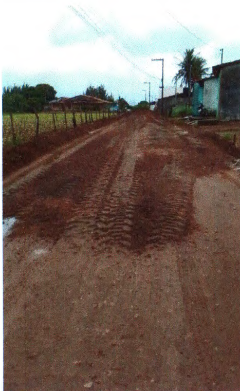
Foto 01: Regularização e compactação de subleito de solo.
