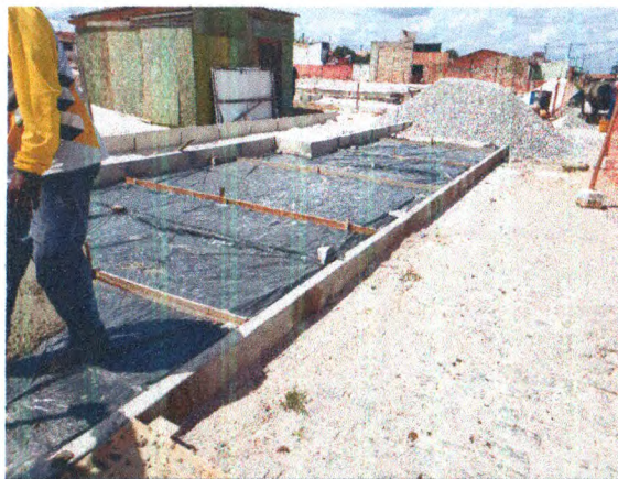
ASSENTAMENTO DE MEIO FIO; LONA PLÁSTICA; PISO EM CONCRETO
