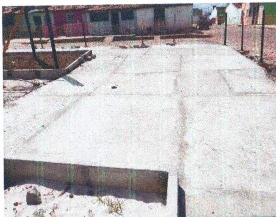
ASSENTAMENTO DE MEIO FIO; PISO EM CONCRETO; RAMPA PARA ACESSO DE DEFICIENTE
