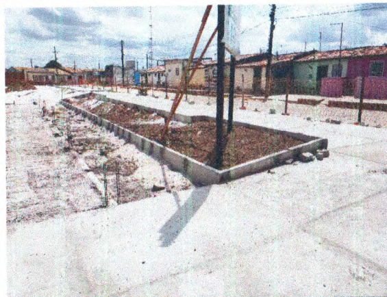
ASSENTAMENTO DE MEIO FIO; PISO EM CONCRETO
