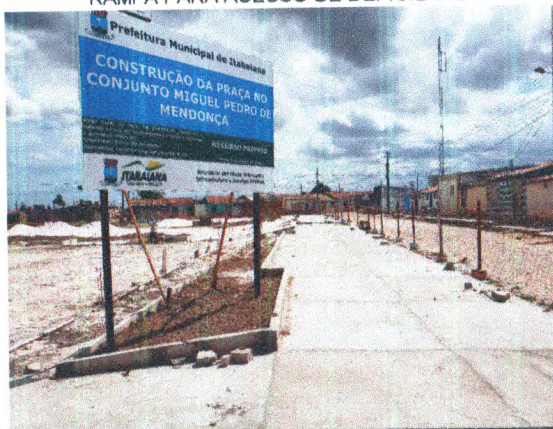
ASSENTAMENTO DE MEIO FIO; PISO EM CONCRETO; PLACA DA OBRA
