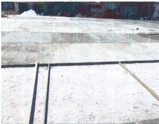
ATERRO COMPACTADO; CAMADA IMPERMEABILIZADORA
