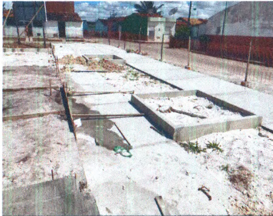
ASSENTAMENTO DE MEIO FIO; ATERRO COMPACTADO; PISO EM CONCRETO
