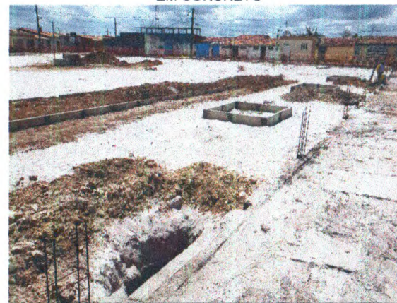
ASSENTAMENTO DE MEIO FIO; ATERRO COMPACTADO
