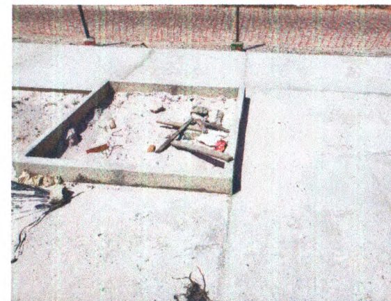
ASSENTAMENTO DE MEIO FIO; PISO EM CONCRETO
