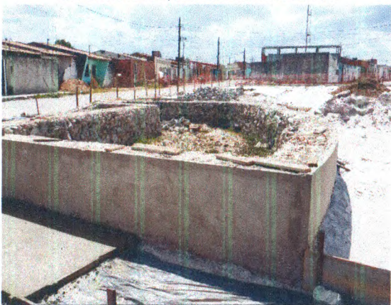
LONA PLÁSTICA; PISO EM CONCRETO; ALVENARIA DE PEDRA
