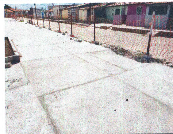
ASSENTAMENTO DE MEIO FIO; PISO EM CONCRETO; RAMPA PARA ACESSO DE DEFICIENTE
