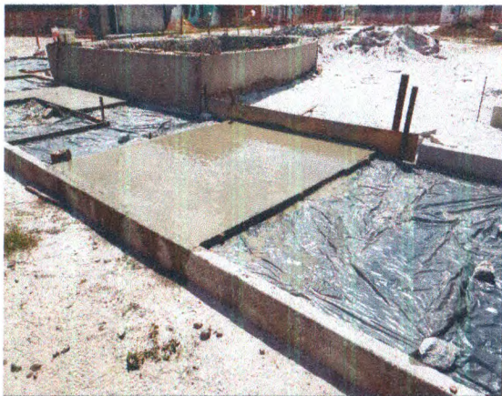
ASSENTAMENTO DE MEIO FIO; LONA PLÁSTICA; PISO EM CONCRETO; ALVENARIA DE PEDRA
