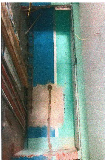
REBOCO DE PAREDE
