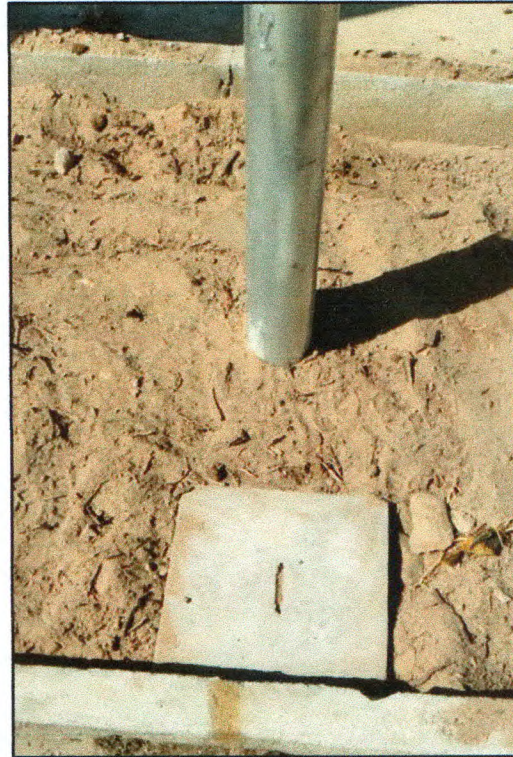
Figura 2: Instalação de caixas de passagem
