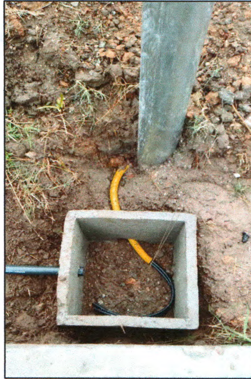
Figura 4: Inst. de eletroduto flexível e cx de passagem
