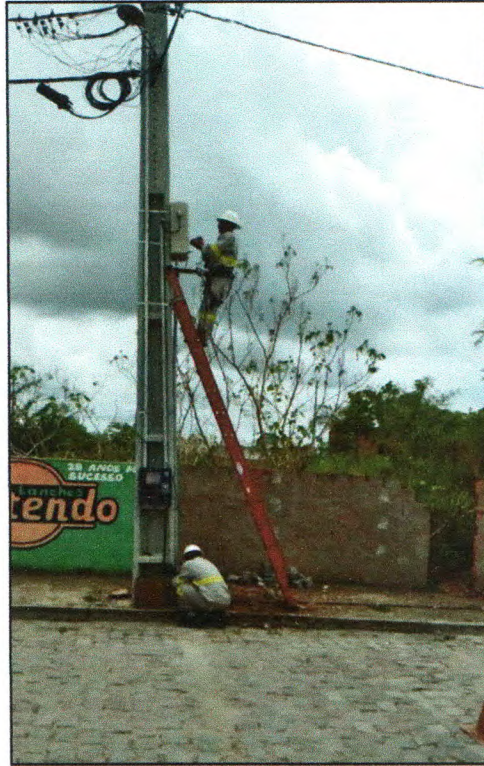
Figura 14: Alimentação do comando e medição
