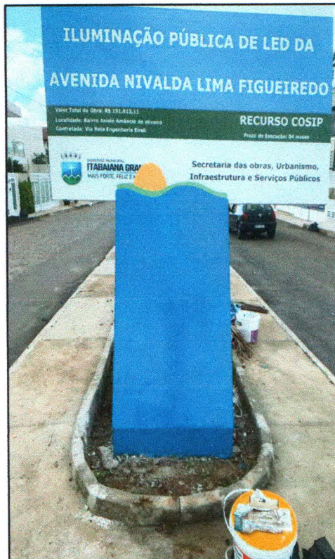
Figura 20: Construção de marco inaugural
