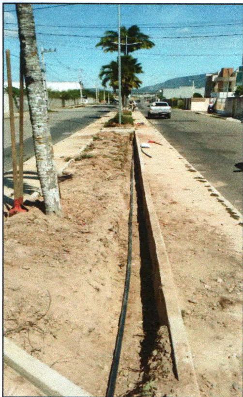
Figura 7: Instalação de eletroduto pvc rígido
