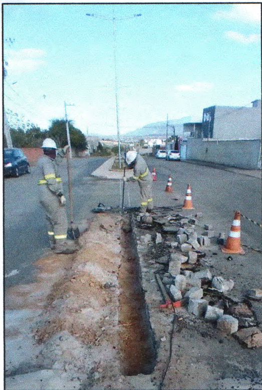
Figura 5: Escavação de vala manual em travessias
