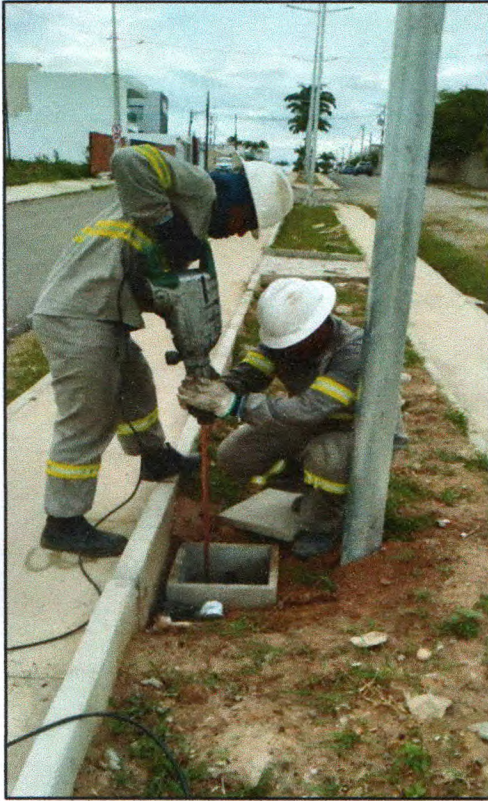
Figura 15: Instalação de hastes terra
