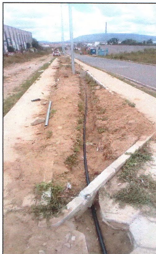
Figura 8: Instalação de eletroduto pvc rígido
