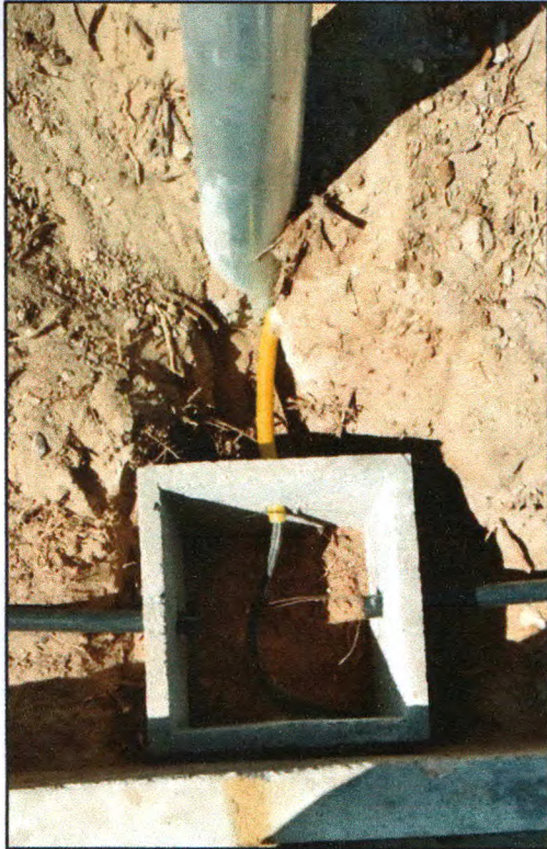
Figura 3: Inst. de eletroduto flexível e cx de passagem
