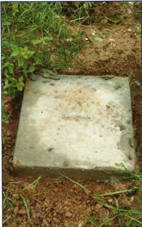
Figura 19:Caixas de passagem chumbadas
