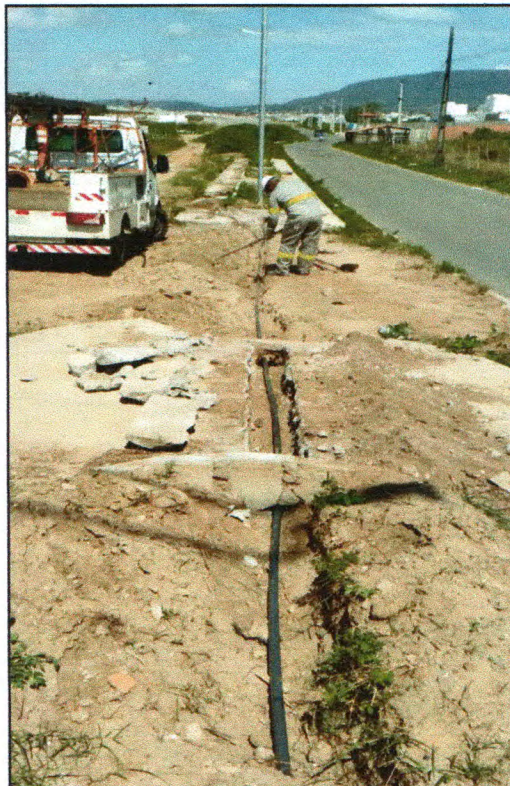
Figura 6: Escavação de vala manual em travessias
