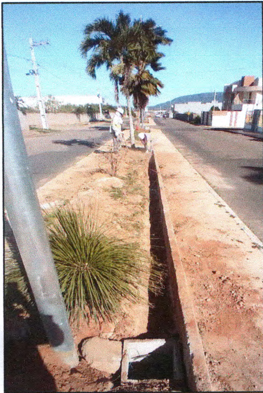
Figura 1: Escavação de vala manual
