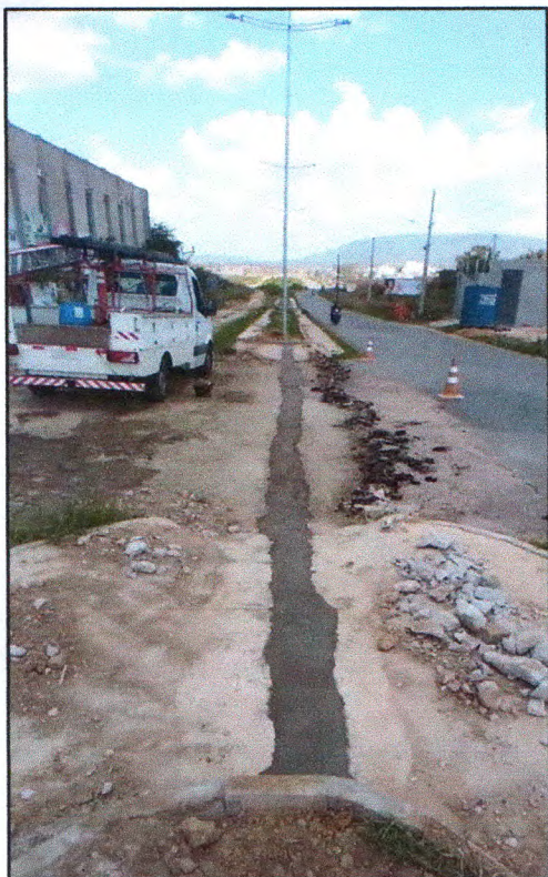
Figura 9: Concretagem de travessias
