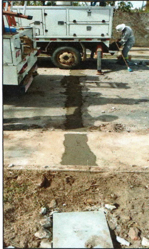
Figura 12: Concretagem de travessia
