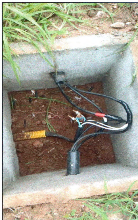
Figura 18: Ligação de hastes e circuitos
