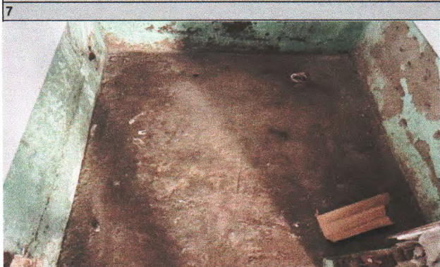
Imagem 7 - Regularização da base para revestimento
