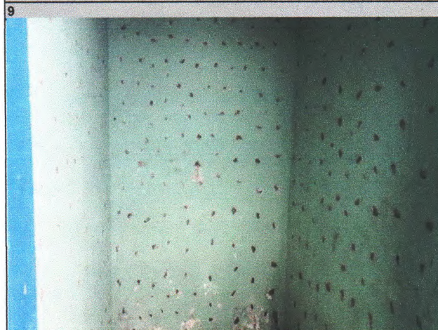
Imagem 9 - Apicoamento total de reboco com ponteiros/talhadeiras
