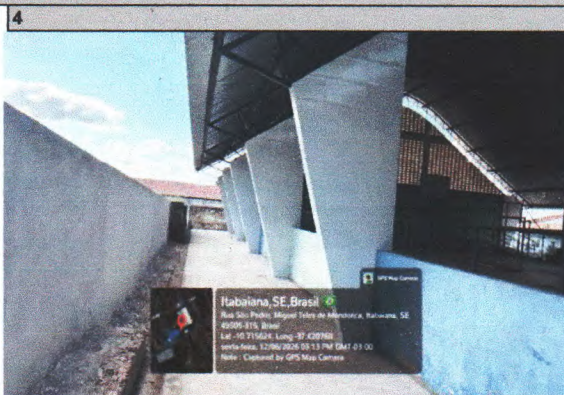
Imagem 4 - Revestimento cerâmico dos pilares da quadra
