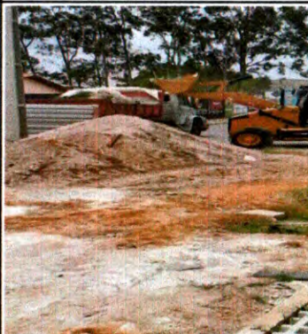
ESCAVAÇÃO E ATERRO PARA MEIO-FIO PRÉ MOLDADO
