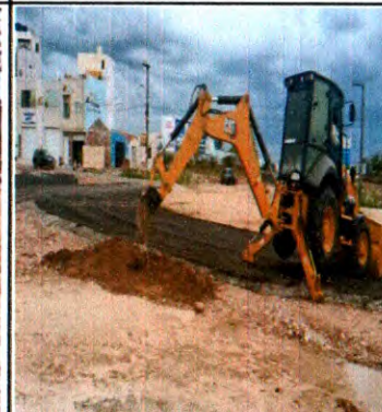
ESCAVAÇÃO E ATERRO PARA MEIO-FIO PRÉ MOLDADO
