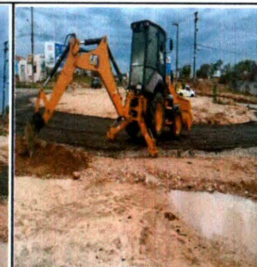
ESCAVAÇÃO E ATERRO PARA MEIO-FIO PRÉ MOLDADO
