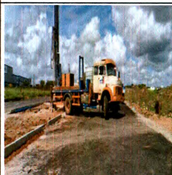
PERFURAÇÃO, REVESTIMENTO E CIMENTAÇÃO DO POÇO ARTESIANO
