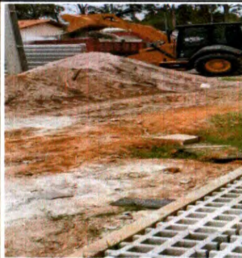
ESCAVAÇÃO E ATERRO PARA MEIO-FIO PRÉ MOLDADO
