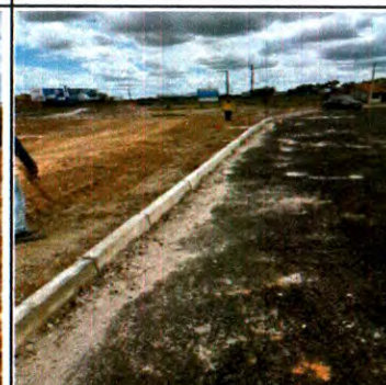
MEIO-FIO PRÉ MOLDADO DE CONCRETO
