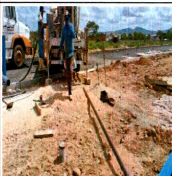
PERFURAÇÃO, REVESTIMENTO E CIMENTAÇÃO DO POÇO ARTESIANO
