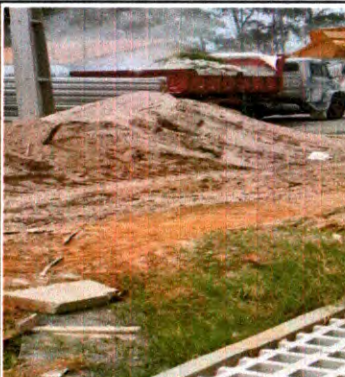
ESCAVAÇÃO E ATERRO PARA MEIO-FIO PRÉ MOLDADO
