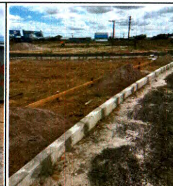
MEIO-FIO PRÉ MOLDADO DE CONCRETO
