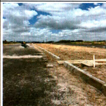
MEIO-FIO PRÉ MOLDADO DE CONCRETO
