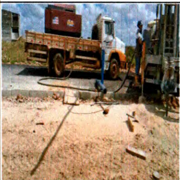
PERFURAÇÃO, REVESTIMENTO E CIMENTAÇÃO DO POÇO ARTESIANO
