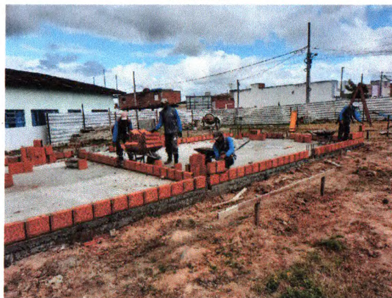
MARCAÇÃO DA ALVENARIA DE BLOCO
