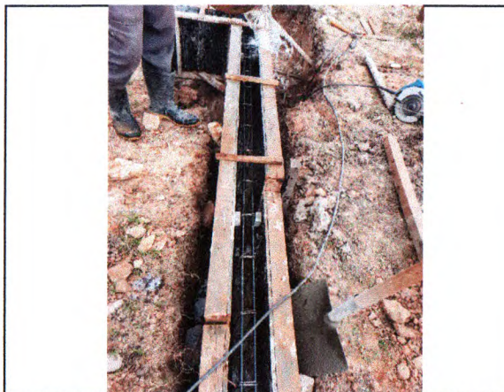
ESCAVAÇÃO; ALVENARIA DE PEDRA; VIGAMENTO INFERIOR - FORMA E FERRAGEM
