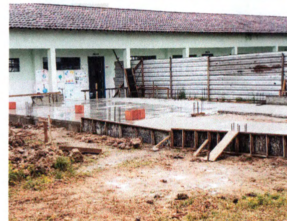
EXECUÇÃO DA CAMADA IMPERMEABILIZADORA
