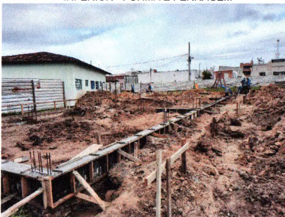
ESCAVAÇÃO; ALVENARIA DE PEDRA; VIGAMENTO INFERIOR - FORMA E CONCRETO ARMADO
