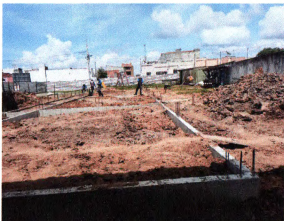
DESFORMA DO VIGAMENTO INFERIOR; REATERRO MANUAL
