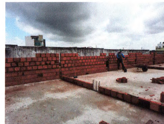
ALVENARIA DE BLOCO CERÂMICO
