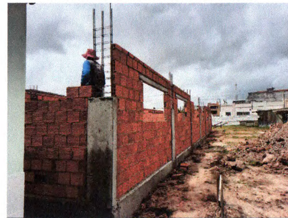
ALVENARIA DE BLOCO CERÂMICO; PILARES, VERGA E CONTRAVERGA EM CONCRETO ARMADO
