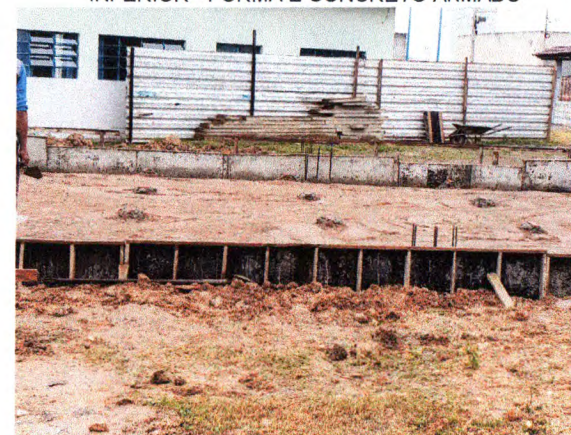
ATERRO COMPACTADO; MESTRAS DA CAMADA IMPERMEABILIZADORA
