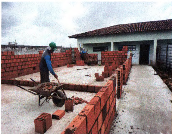
ALVENARIA DE BLOCO CERÂMICO
