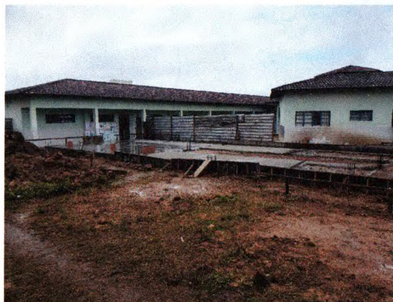
EXECUÇÃO DA CAMADA IMPERMEABILIZADORA
