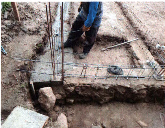
ESCAVAÇÃO; ALVENARIA DE PEDRA; FERRAGEM DO VIGAMENTO INFERIOR
