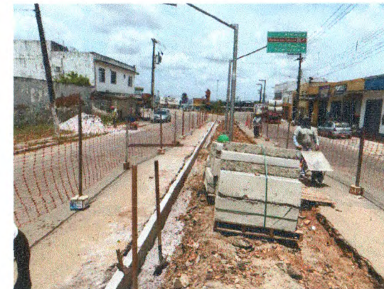
TAPUME DE PROTEÇÃO EM TELA; ASSENTAMENTO DE MEIO-FIO EM CONCRETO; REATERRO MANUAL
