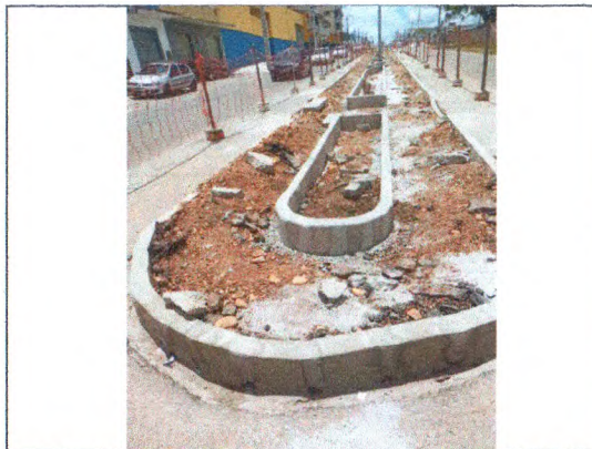
CORTE DO ASFALTO; TAPUME DE PROTEÇÃO EM TELA; MEIO-FIO EM CONCRETO; REATERRO MANUAL
