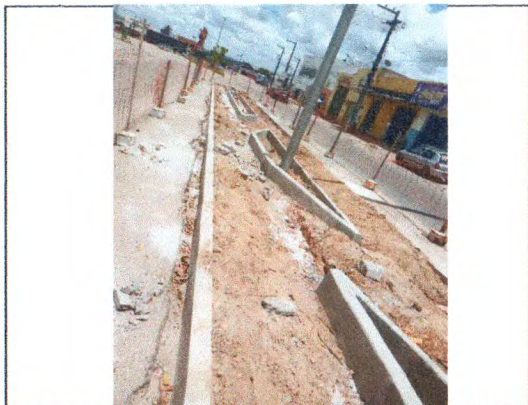
CORTE DO ASFALTO; TAPUME DE PROTEÇÃO EM TELA; MEIO-FIO EM CONCRETO; REATERRO MANUAL
