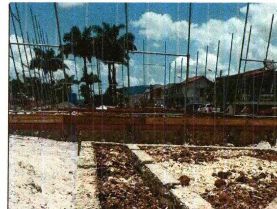
PILARES, CINTA SUPERIOR, ALVENARIA DE PEDRA E ALVENARIA CERÂMICA DA QUADRA
