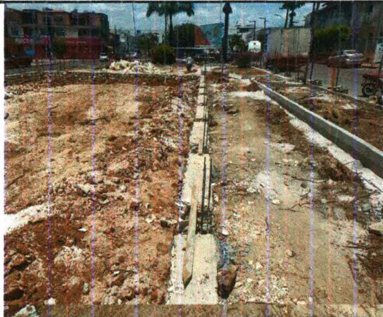
MEIO-FIO, ALVENARIA DE PEDRA E CONCRETO MAGRO
