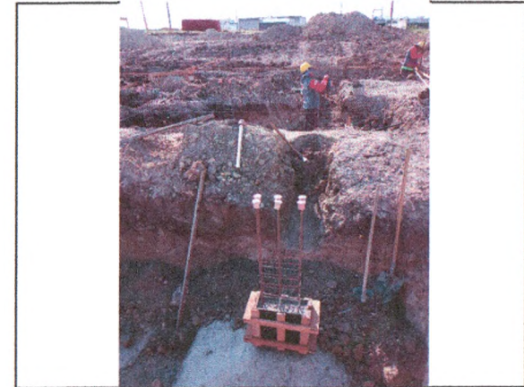
ADMINISTRAÇÃO - ESCAVAÇÃO; CONCRETO MAGRO; FORMA; FERRAGEM; CONCRETAGEM DA SAPATA
