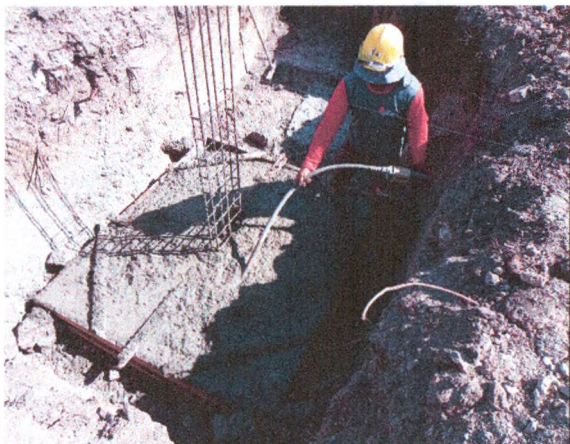
ADMINISTRAÇÃO - ESCAVAÇÃO; CONCRETO MAGRO; FORMA; FERRAGEM; CONCRETAGEM DA SAPATA
