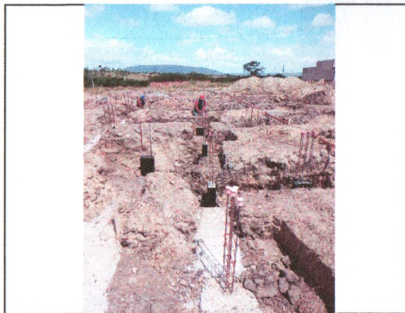
GABARITO DE MADEIRA; CONCRETO ARMADO DAS SAPATAS E ARRANQUES
