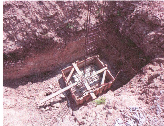
GUARITA - ESCAVAÇÃO; CONCRETO MAGRO; FORMA; FERRAGEM
