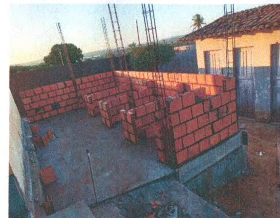
BANHEIROS NOVOS - CONCRETO ARMADO; ALVENARIA DE BLOCO CERÂMICO
