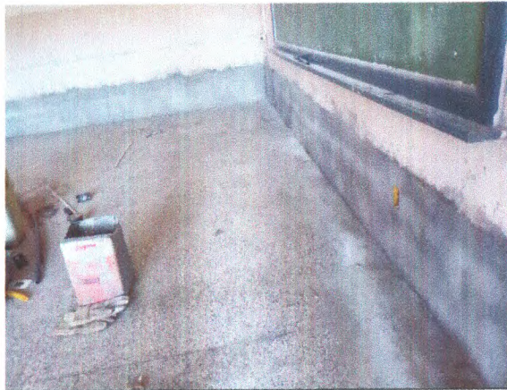
CHAPISCO E REBOCO INTERNO
