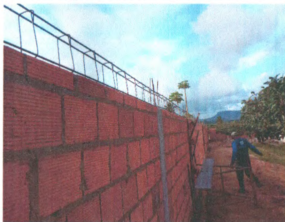
MURO - CINTAMENTO; PILARES EM CONCRETO ARMADO; ALVENARIA DE BLOCO
