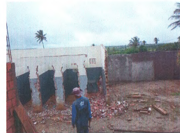
DEMOLIÇÃO DOS BANHEIROS VELHOS
