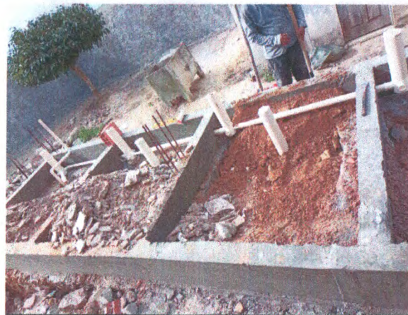
BANHEIROS NOVOS - CONCRETO ARMADO; INSTALAÇÕES SANITÁRIAS
