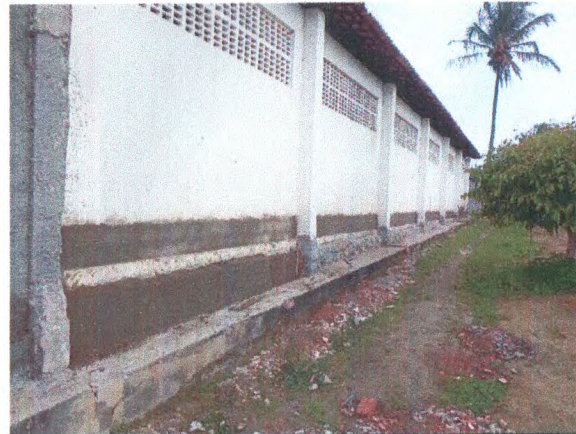
CHAPISCO E REBOCO EXTERNO
