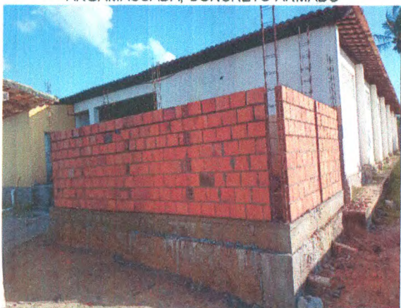
BANHEIROS NOVOS - ALVENARIA DE PEDRA ARGAMASSADA; CONCRETO ARMADO; ALVENARIA DE BLOCO CERÂMICO
