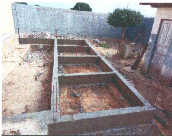
BANHEIROS NOVOS - ALVENARIA DE PEDRA ARGAMASSADA; CONCRETO ARMADO
