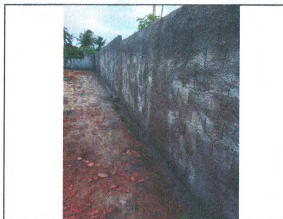
MURO - CINTAMENTO; PILARES EM CONCRETO ARMADO; ALVENARIA DE BLOCO; CHAPISCO
