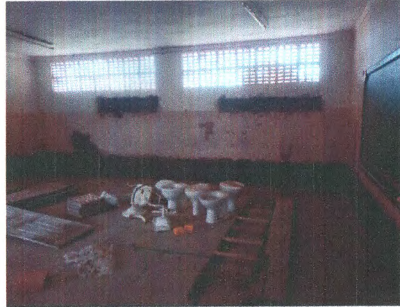
CHAPISCO E REBOCO INTERNO
