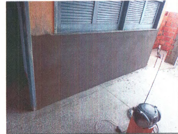
CHAPISCO E REBOCO INTERNO
