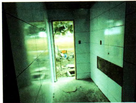
FOTOS 5. Retelhamento após a lavagem das telhas, instalação de caixões e reboco, instalação de revestimento na cozinha e pontos de energia
