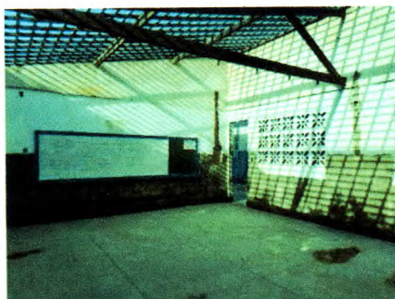
FOTOS 19. Remoção de telhado, revestimento, limpeza de telhas, troca de madeiramento danificado, execução de chapisco e reboco no bloco das salas de aula
