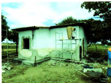
FOTOS 7. Fotos externas da casa do vigia com rebocos, recuperação de passeio, emassamentos dos beirais do telhado, instalação de esquadrias de madeira
