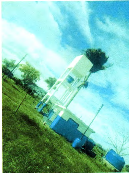
FOTOS 16. Emassamento e pintura da Casa de Bombas e Caixa d'água
