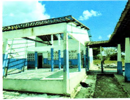
FOTOS 21. Demolição e execução de chapisco e reboco nas salas de aula. Instalação de novos caixões de porta
