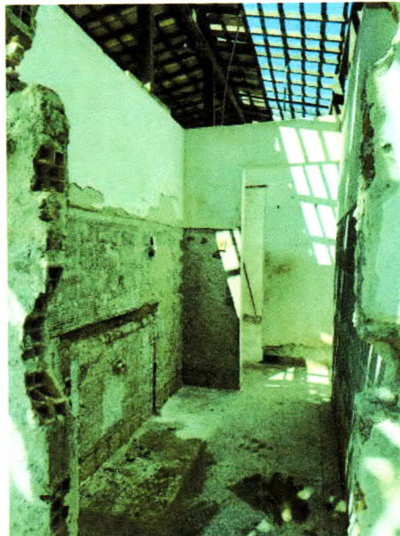
FOTOS 3. Demolição de revestimento, demolição de reboco e destelhamento da casa do vigia
