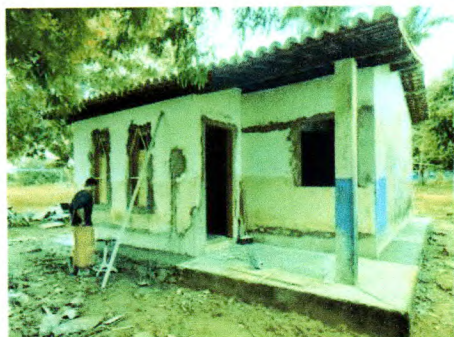
FOTOS 7. Fotos externas da casa do vigia com rebocos, recuperação de passeio, emassamentos dos beirais do telhado, instalação de esquadrias de madeira
