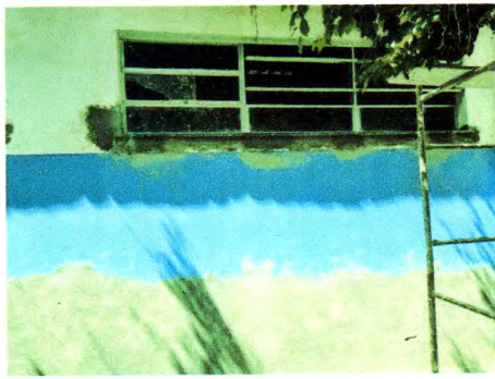
FOTOS 20. Execução de chapisco e reboco no bloco das salas de aula, após demolição do antigo
