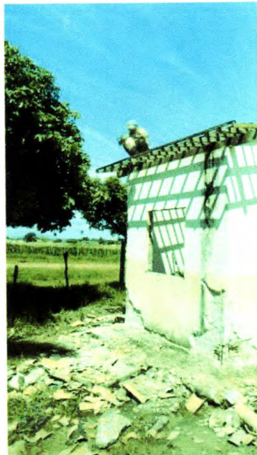
FOTOS 8. Remoção do passeio, execução de chapisco com reboco, instalação de caixões
