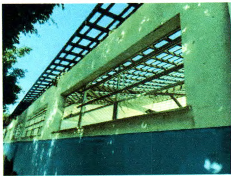
FOTOS 18. Remoção de telhado, revestimento, limpeza de telhas, troca de madeiramento danificado, execução de chapisco e reboco no bloco das salas de aula
