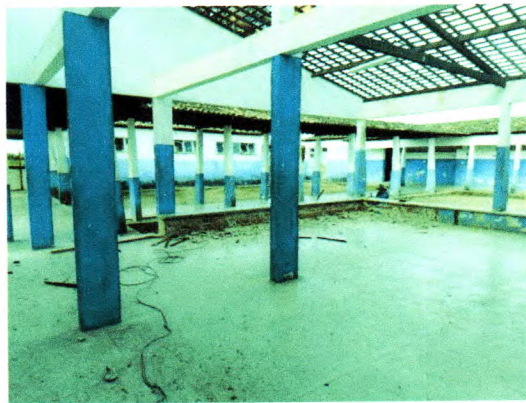
FOTOS 22. Retelamento após a lavagem das telhas e Demolição e execução de chapisco e reboco nas salas de aula.
