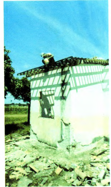
FOTOS 8. Remoção do passeio, execução de chapisco com reboco, instalação de caixões
