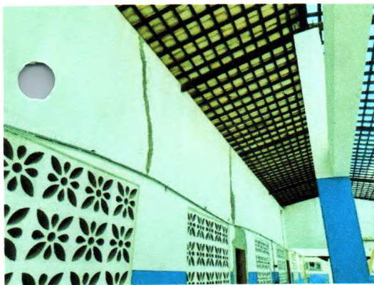
FOTOS 22. Retelamento após a lavagem das telhas e Demolição e execução de chapisco e reboco nas salas de aula.
