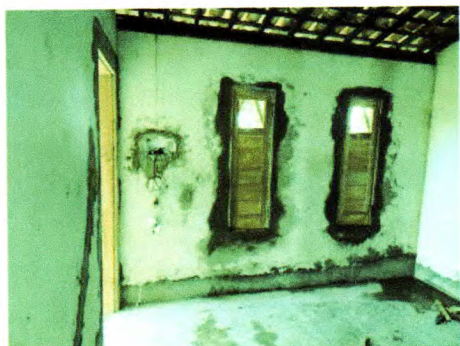
FOTOS 6. Instalação de esquadrias de madeira, retelhamento, rebocos internos, passeio externo
