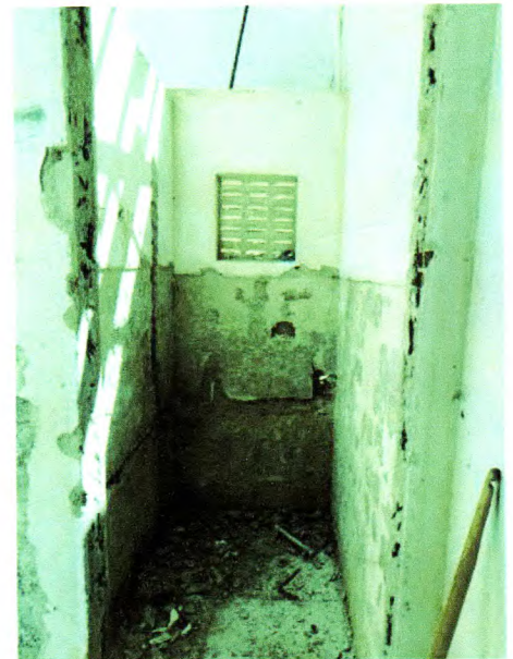
FOTOS 3. Demolição de revestimento, demolição de reboco e destelhamento da casa do vigia
