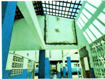
FOTOS 21. Demolição e execução de chapisco e reboco nas salas de aula. Instalação de novos caixões de porta
