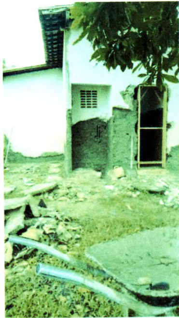
FOTOS 8. Remoção do passeio, execução de chapisco com reboco, instalação de caixões
