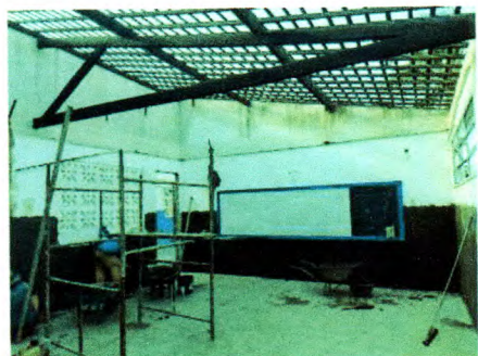
FOTOS 19. Remoção de telhado, revestimento, limpeza de telhas, troca de madeiramento danificado, execução de chapisco e reboco no bloco das salas de aula
