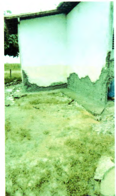
FOTOS 8. Remoção do passeio, execução de chapisco com reboco, instalação de caixões
