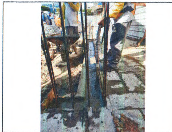
Estrutura em concreto armado
