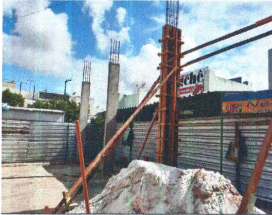
Estrutura em concreto armado
