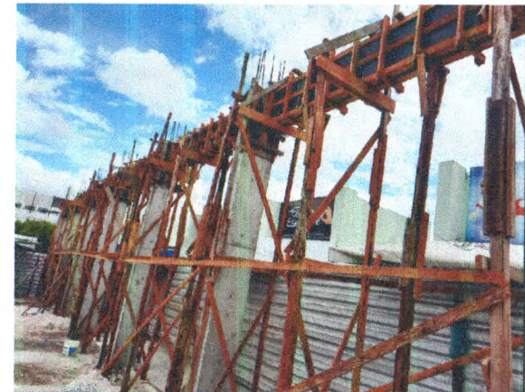
Estrutura em concreto armado
