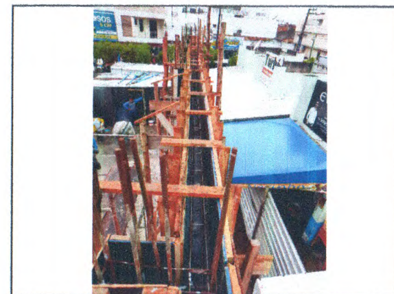
Estrutura em concreto armado
