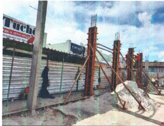
Estrutura em concreto armado
