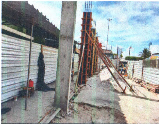
Estrutura em concreto armado
