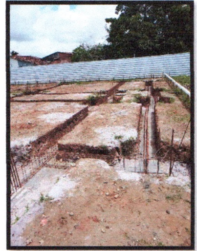
Figura 3: Colocação de armadura das vigas baldrames nas valas
