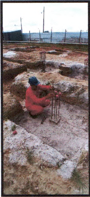
Figura 10: Execução de mestra para concreto magro de viga baldrame
