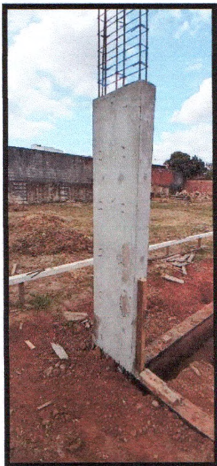
Figura 38: Retirada de forma de pilar concretado
