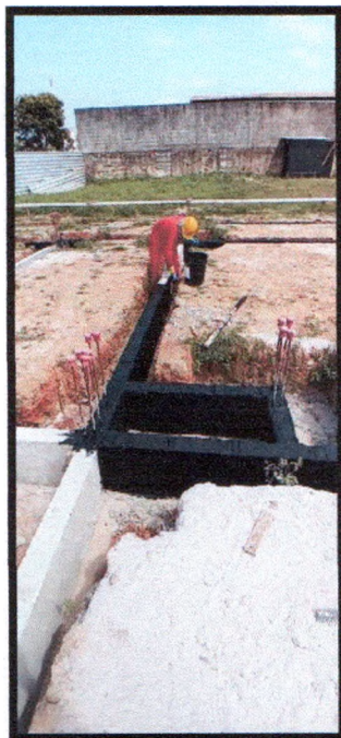
Figura 26: Impermeabilização das vigas baldrames
