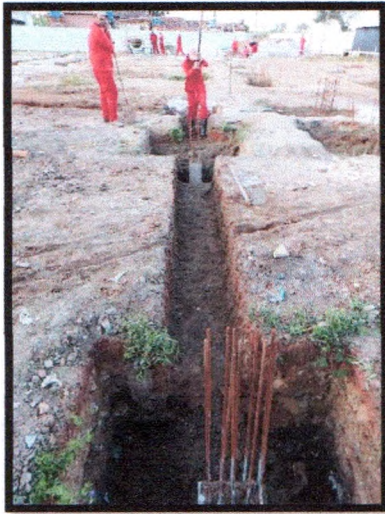
Figura 1: Escavação de vala para vigas baldrames
