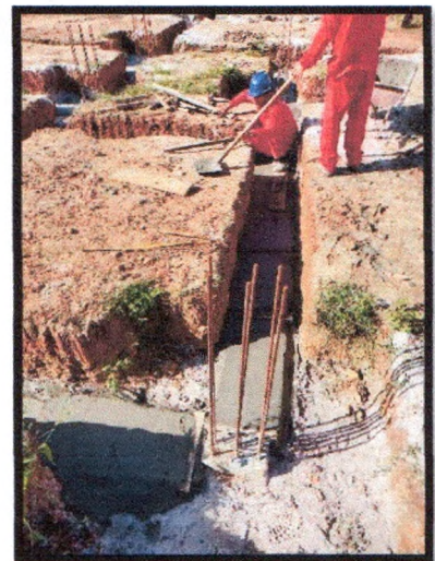
Figura 6: Execução de concreto magro das vigas baldrames
