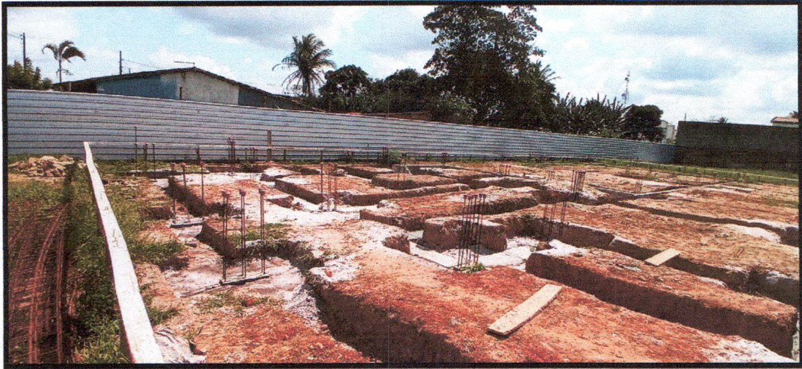
Figura 15: Escavação de valas para execução de vigas baldrame
