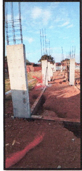
Figura 40: Colocação de armação de pilar
