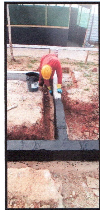
Figura 28: Impermeabilização das vigas baldrames
