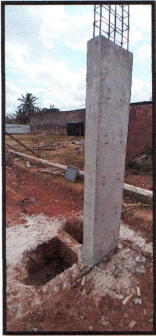
Figura 38: Retirada de forma de pilar concretado
