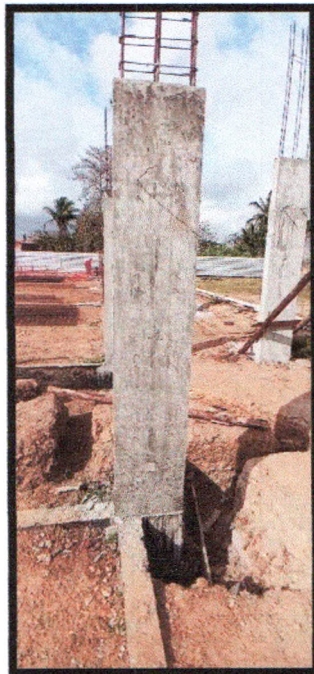
Figura 39: Retirada de forma de pilar concretado
