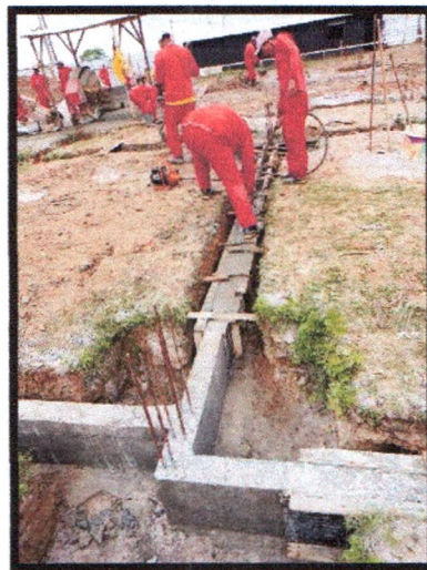
Figura 5: Concretagem de vigas baldrames
