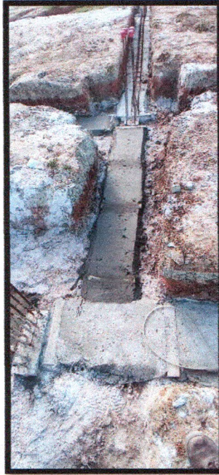
Figura 11: Execução de lastro de concreto magro de viga baldrame
