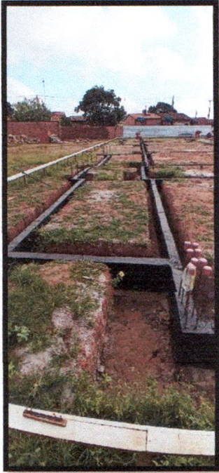
Figura 26: Impermeabilização das vigas baldrames
