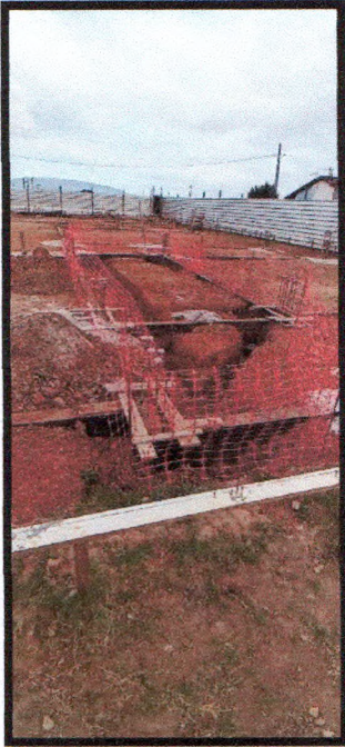
Figura 32: Colocação de armação para montagem de forma de pilar
