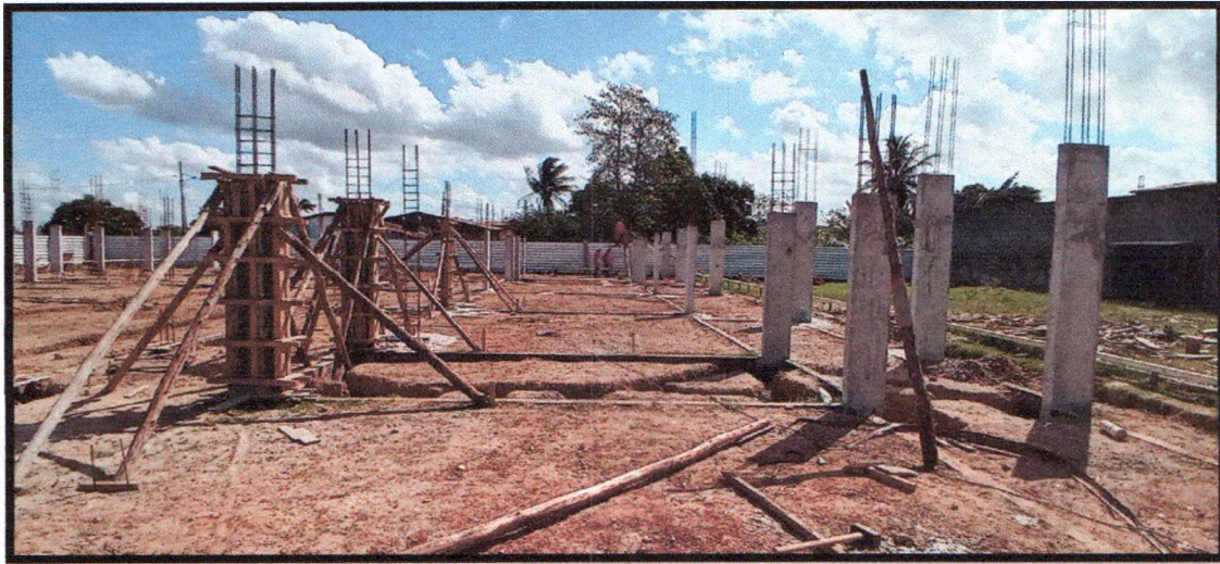
Figura 41: Vista geral da obra
