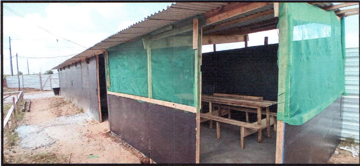
Figura 13: Execução de refeitório
