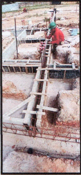
Figura 20: Concretagem de vigas baldrames
