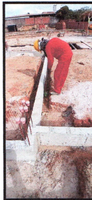
Figura 27: Impermeabilização das vigas baldrames
