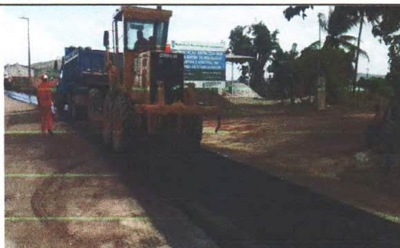
FOTO 06 - APLICAÇÃO DE PAVIMENTAÇÃO ASFÁLTICA
