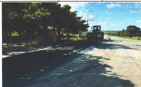
FOTO 08 - APLICAÇÃO DE PAVIMENTAÇÃO ASFÁLTICA
