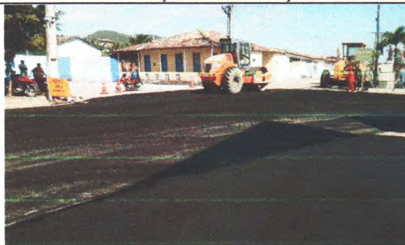
FOTO 08 - APLICAÇÃO DE PAVIMENTAÇÃO ASFÁLTICA
