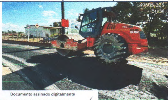
FOTO 07 - APLICAÇÃO DE PAVIMENTAÇÃO ASFÁLTICA
