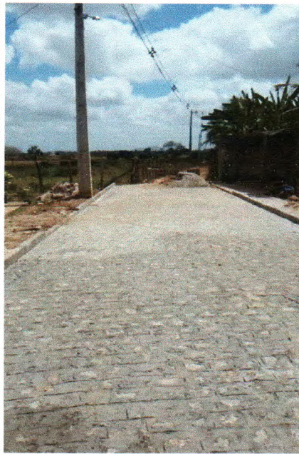
PAVIMENTAÇÃO E MEIO FIO TANQUE VERMELHO 04
