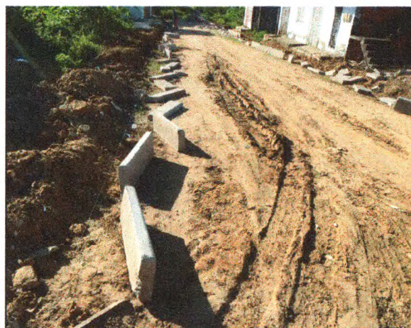
REGULARIZAÇÃO DO TERRENO NA TRV. MARIA DO CÉU
