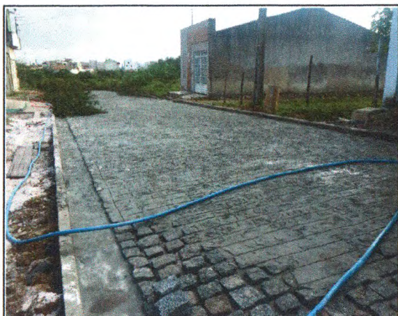
PAVIMENTAÇÃO NA TRV. MARIA DO CÉU
