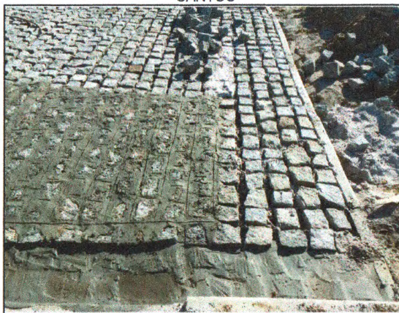
PAVIMENTAÇÃO NA RUA JOSIVAL DOS SANTOS
