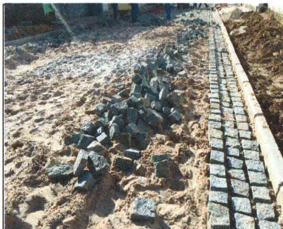
COLCHÃO DE AREIA, MEIO FIO E PARALELEPIPEDO NA TRV. JOSEFA MAXIMA DOS SANTOS
