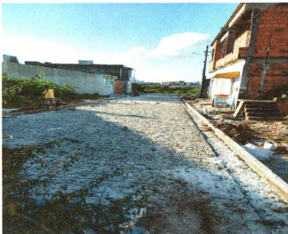
PAVIMENTAÇÃO NA TRV. MARIA DO CÉU
