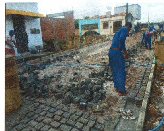
COLCHÃO DE AREIA, MEIO FIO E PARALELEPIPEDO NA TRV. MARIA DO CÉU
