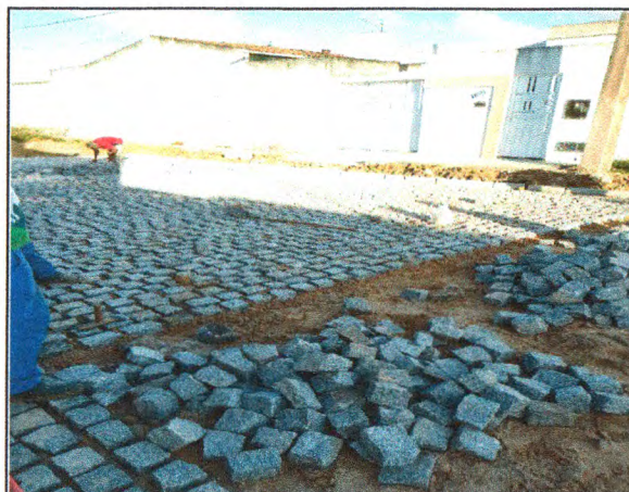
COLCHÃO DE AREIA, MEIO FIO E PARALELEPIPEDO NA RUA JOSIVAL NUNES DOS SANTOS
