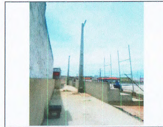
IMPLANTAÇÃO DE POSTE E CRUZETA DE CONCRETO.
