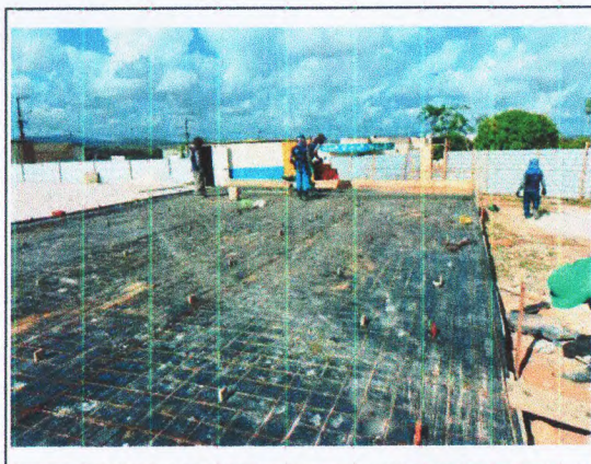
EXECUÇÃO CAMADA DA QUADRA.
