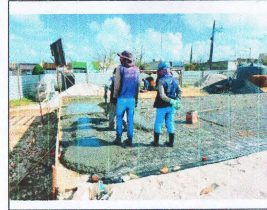
EXECUÇÃO CAMADA DA QUADRA.
