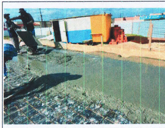
EXECUÇÃO CAMADA DA QUADRA.
