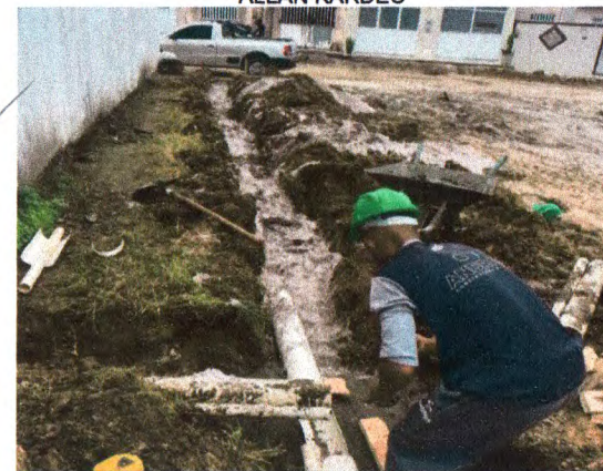
ASSENTAMENTO DA TUBULAÇÃO NA RUA ALLAN KARDEC
