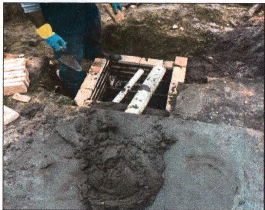
MONTAGEM DA CAIXA DE PASSAGEM PARA ESGOTO NA RUA JOSÉ BRAZ SANTOS
