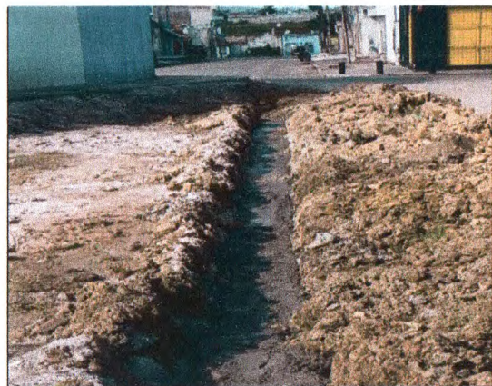
ESCAVAÇÃO PARA TUBULAÇÃO DE ESGOTO NAS RUAS ARGENTINA E PROJETADA
