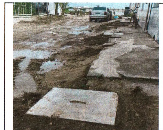
CAIXA DE PASSAGEM PARA ESGOTO NA RUA ALLAN KARDEC
