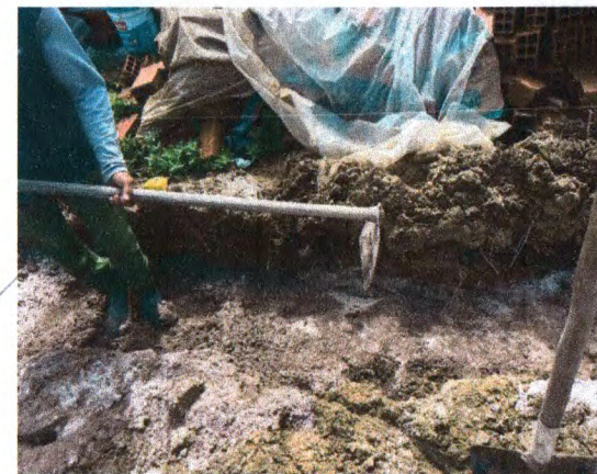
ESCAVAÇÃO PARA TUBULAÇÃO DE ESGOTO NA RUA ALLAN KARDEC
