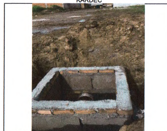
CAIXA DE PASSAGEM DE ESGOTO NA RUA PROJETADA
