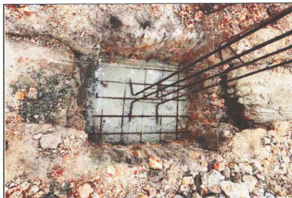
FUNDAÇÕES DA AMPLIAÇÃO
