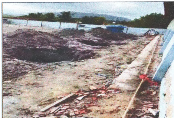
MOVIMENTO DE TERRA DA QUADRA
