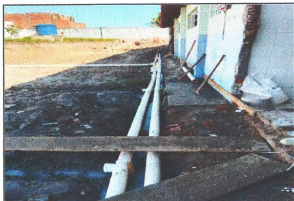
INSTALAÇÕES SANITÁRIAS E DE DRENAGEM
