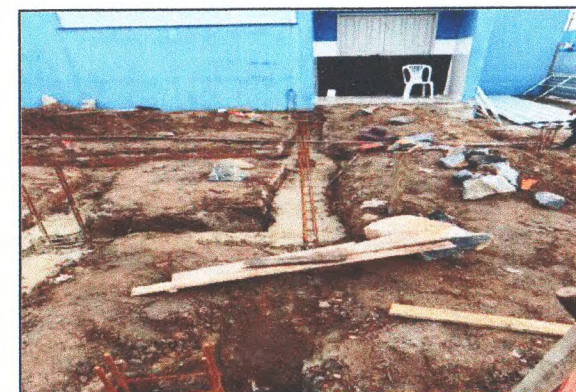
FUNDAÇÕES DA AMPLIAÇÃO
