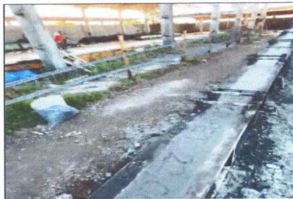
ESTRUTURA DA QUADRA
