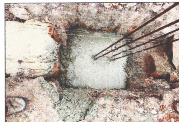
FUNDAÇÕES DA AMPLIAÇÃO
