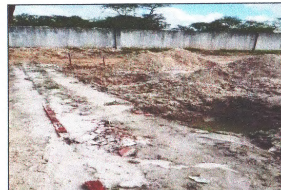
MOVIMENTO DE TERRA DA QUADRA
