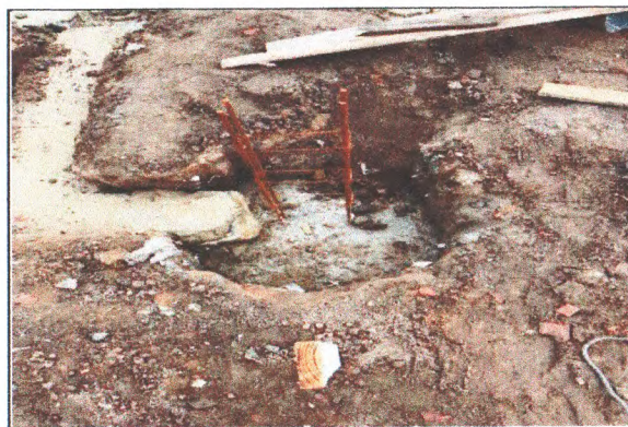
FUNDAÇÕES DA AMPLIAÇÃO
