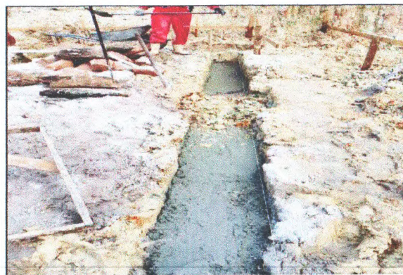
FUNDAÇÕES DA AMPLIAÇÃO
