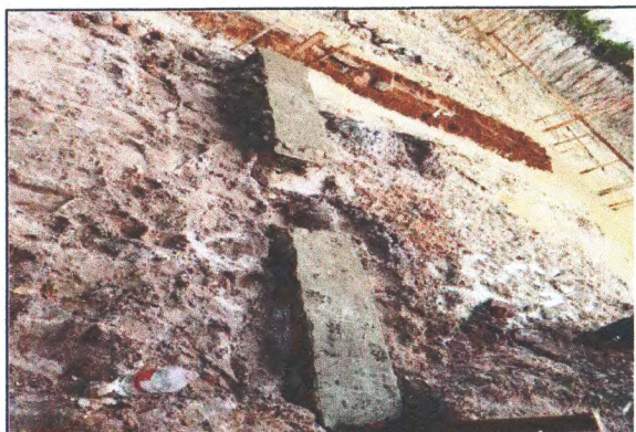
FUNDAÇÕES DA AMPLIAÇÃO
