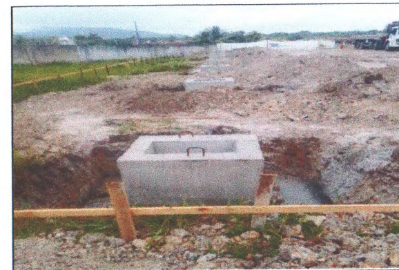
SAPATAS DO GALPÃO DA QUADRA
