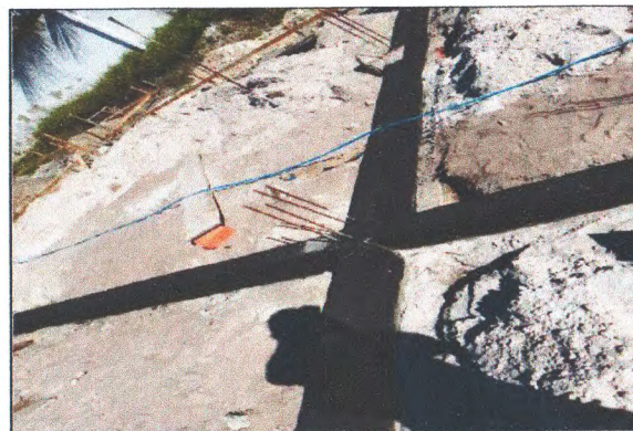
IMPERMEABILIZAÇÃO E ATERRO
