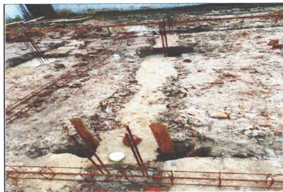
FUNDAÇÕES DA AMPLIAÇÃO
