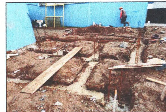
FUNDAÇÕES DA AMPLIAÇÃO
