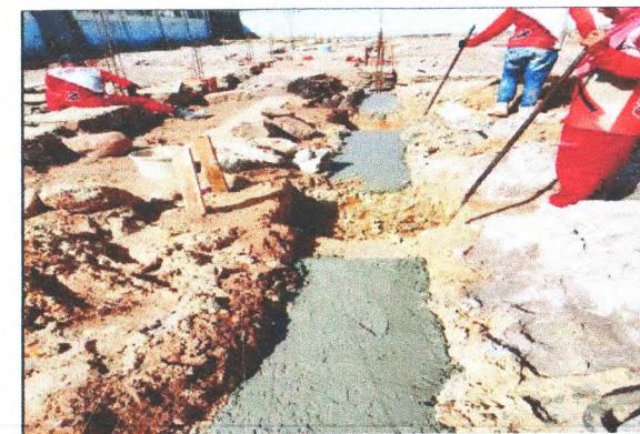
FUNDAÇÕES DA AMPLIAÇÃO
