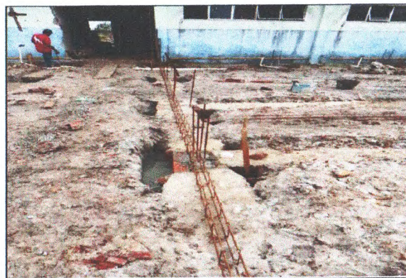
FUNDAÇÕES DA AMPLIAÇÃO
