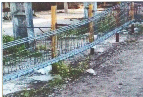
ESTRUTURA DA QUADRA
