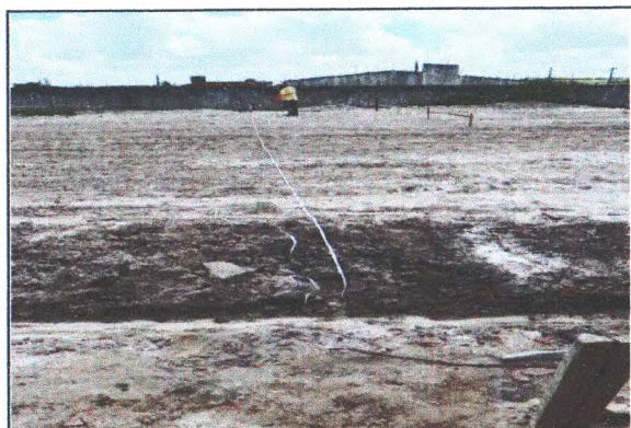
MOVIMENTO DE TERRA DA QUADRA
