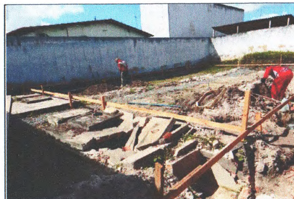
FUNDAÇÕES DA AMPLIAÇÃO
