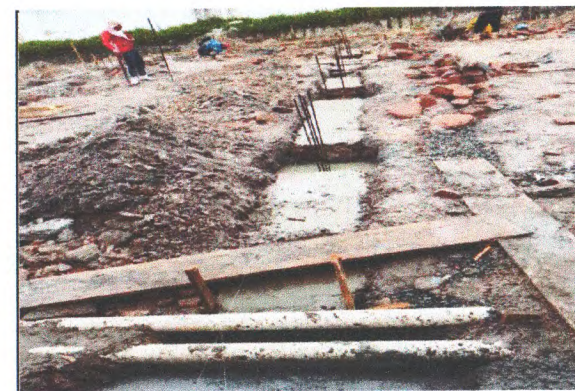
FUNDAÇÕES DA AMPLIAÇÃO
