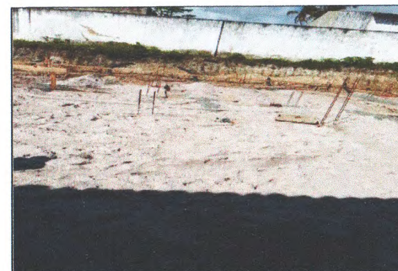
IMPERMEABILIZAÇÃO E ATERRO
