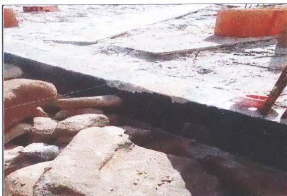
IMPERMEABILIZAÇÃO E ATERRO
