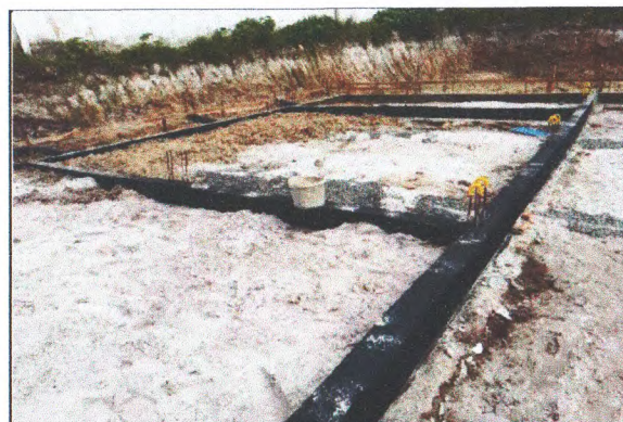
IMPERMEABILIZAÇÃO E ATERRO
