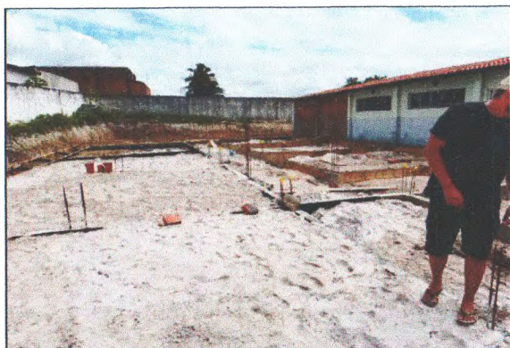
IMPERMEABILIZAÇÃO E ATERRO
