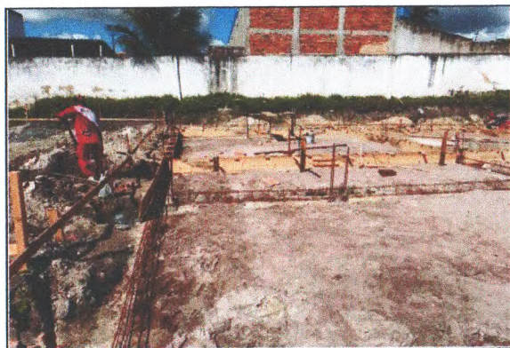
FUNDAÇÕES DA AMPLIAÇÃO
