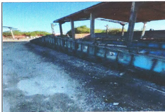
ESTRUTURA DA QUADRA
