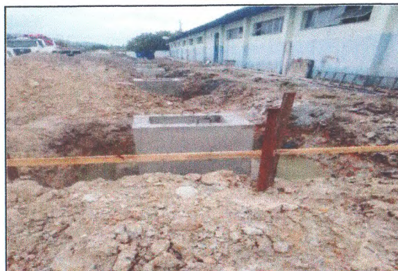
SAPATAS DO GALPÃO DA QUADRA
