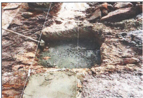
FUNDAÇÕES DA AMPLIAÇÃO
