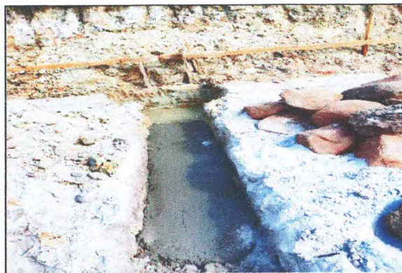
FUNDAÇÕES DA AMPLIAÇÃO
