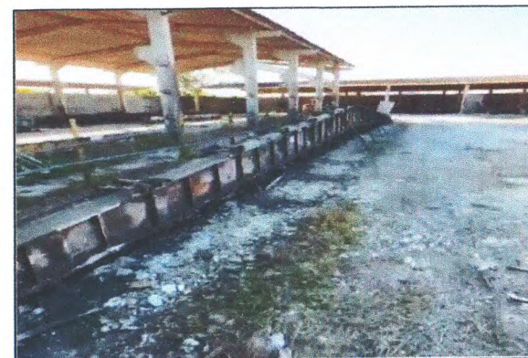
ESTRUTURA DA QUADRA
