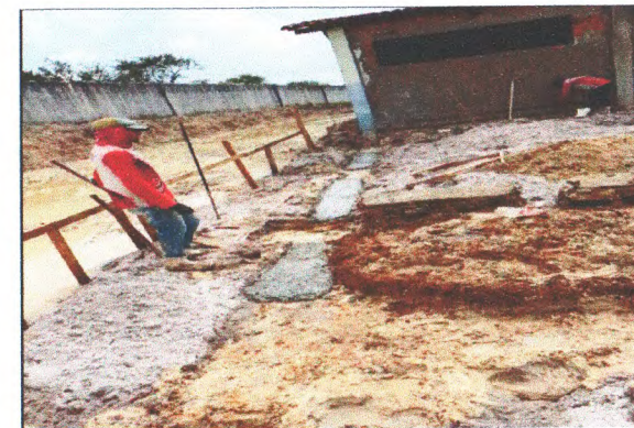
FUNDAÇÕES DA AMPLIAÇÃO
