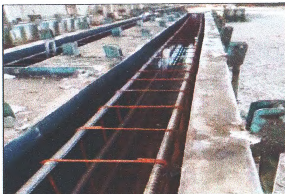
ESTRUTURA DA QUADRA
