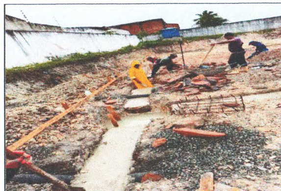
FUNDAÇÕES DA AMPLIAÇÃO
