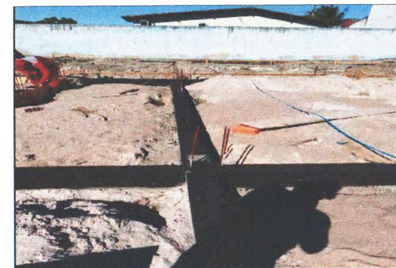
IMPERMEABILIZAÇÃO E ATERRO
