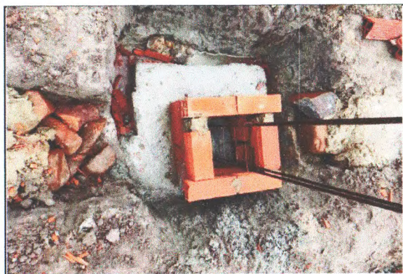
FUNDAÇÕES DA AMPLIAÇÃO
