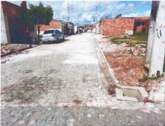
RUA JOSÉ VICENTE DE ALMEIDA - ASSENTAMENTO MEIO-FIO E PARALELEPÍPEDO; DRENAGEM SUPERFICIAL
