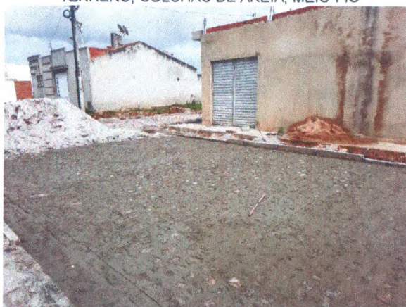
RUA JOSÉ ERALDO SANTOS - ASSENTAMENTO MEIO-FIO E PARALELEPÍPEDO; DRENAGEM SUPERFICIAL
