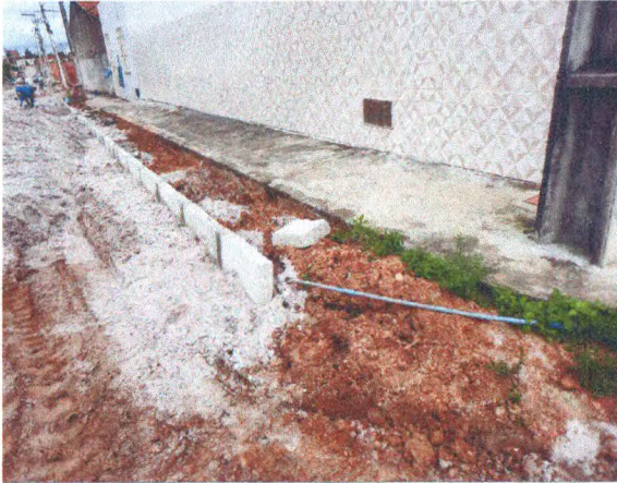
RUA JOSÉ VICENTE DE ALMEIDA - REGULARIZAÇÃO DO TERRENO; COLCHÃO DE AREIA; MEIO-FIO
