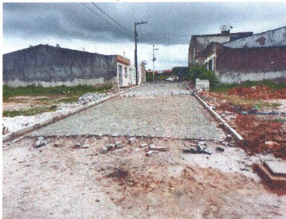
RUA JOSÉ DE SOUZA DANTAS - ASSENTAMENTO MEIO-FIO E PARALELEPÍEDO; DRENAGEM SUPERFICIAL
