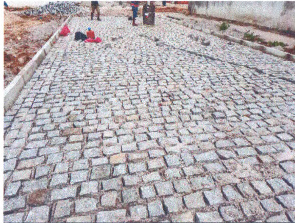
RUA JOSÉ VICENTE DE ALMEIDA - ASSENTAMENTO MEIO-FIO E PARALELEPÍPEDO; DRENAGEM SUPERFICIAL
