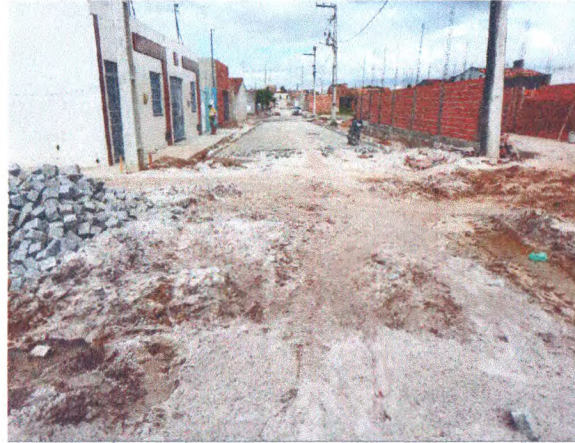
RUA JOSÉ VICENTE DE ALMEIDA - REGULARIZAÇÃO DO TERRENO; COLCHÃO DE AREIA
