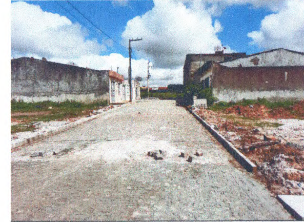
RUA JOSÉ DE SOUZA DANTAS - ASSENTAMENTO MEIO-FIO E PARALELEPÍEDO; DRENAGEM SUPERFICIAL
