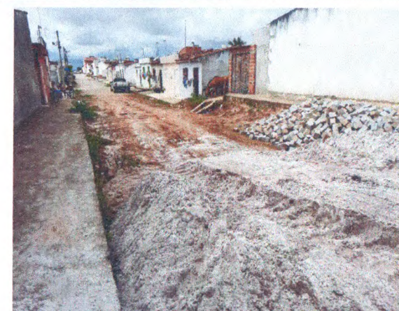
RUA JOSÉ ERALDO SANTOS - REGULARIZAÇÃO DO TERRENO; COLCHÃO DE AREIA
