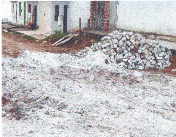
RUA JOSÉ DE SOUZA DANTAS - REGULARIZAÇÃO DO TERRENO; COLCHÃO DE AREIA
