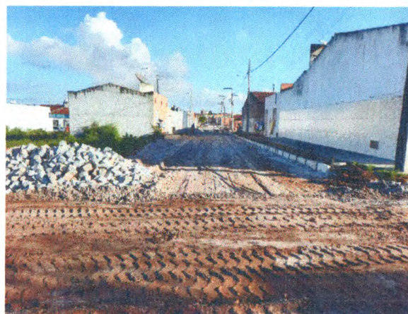
RUA JOSÉ ERALDO SANTOS - REGULARIZAÇÃO DO TERRENO; COLCHÃO DE AREIA; MEIO-FIO
