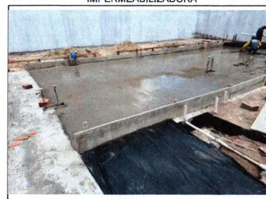
LONA PLÁSTICA E EXECUÇÃO DA CAMADA IMPERMEABILIZADORA
