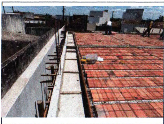
LAJE MACIÇA E VIGAS SUPERIORES
