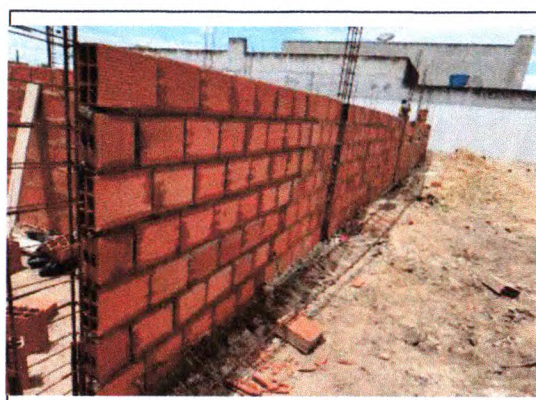
ELEVAÇÃO DE ALVENARIA
