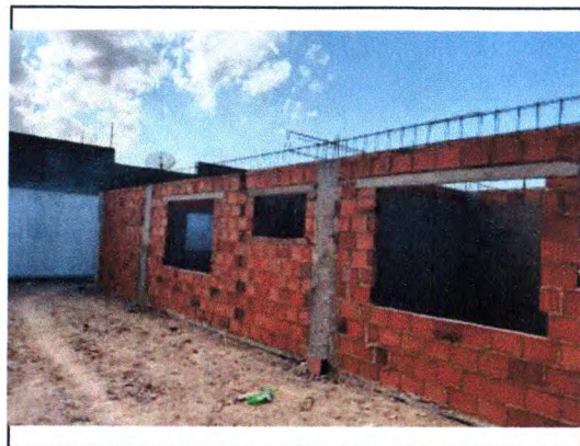
ELEVAÇÃO DE ALVENARIA, VIGAS E PLARES
