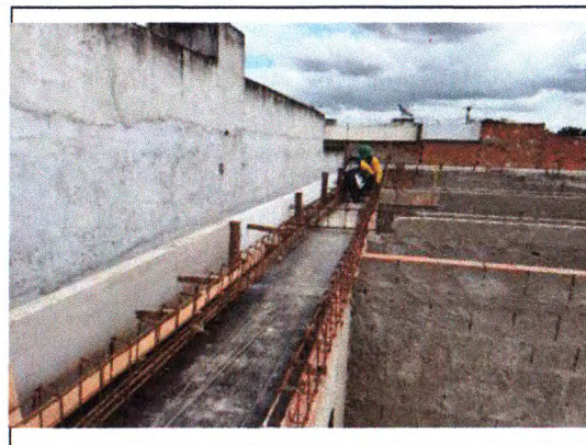
PREPARAÇÃO PARA LAJE MACIÇA
