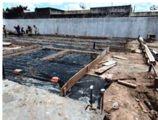
LONA PLÁSTICA E EXECUÇÃO DA CAMADA IMPERMEABILIZADORA
