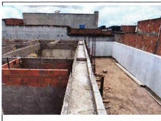
LAJE MACIÇA E VIGAS SUPERIORES
