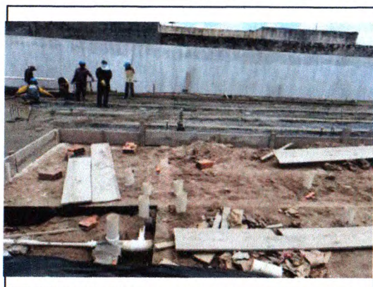
LONA PLÁSTICA E EXECUÇÃO DA CAMADA IMPERMEABILIZADORA
