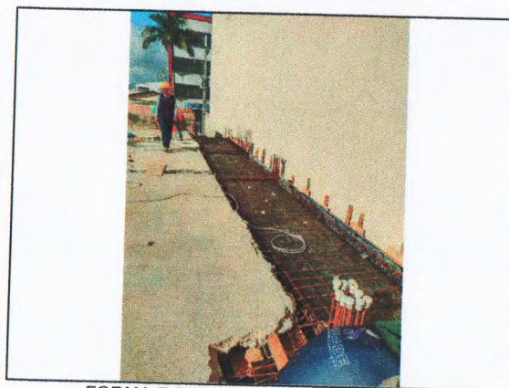
FORMA E FERRAGEM DE VIGAS E LAJE
