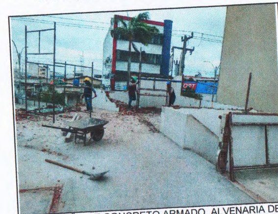
DEMOLIÇÃO DE REVESTIMENTO CERÂMICO
