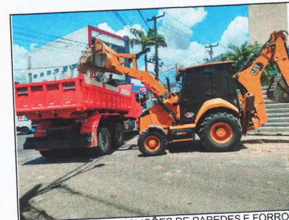
DESCARTE DAS DEMOLIÇÕES DE PAREDES E FORROS DE GESSO, ALVENARIA DE BLOCO CERÂMICO, TELHAMENTO CERÂMICO, CALHAS
