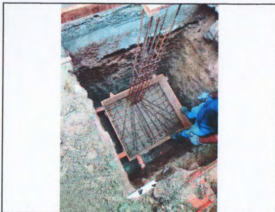
ESCAVAÇÃO; CONCRETO MAGRO; FORMA E FERRAGEM DA SAPATA E ARRANQUE PILAR
