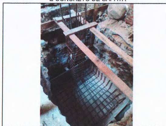
ESCAVAÇÃO; CONCRETO MAGRO; FORMA; FERRAGEM DA SAPATA E ARRANQUE PILAR
