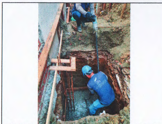
ESCAVAÇÃO; CONCRETO MAGRO; FORMA; FERRAGEM E CONCRETO DE SAPATA
