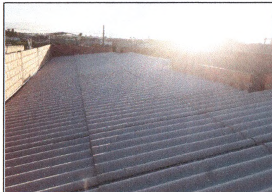
Execução do telhamento 02
