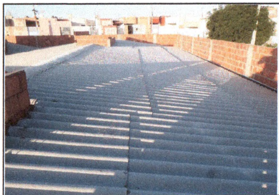
Execução do telhamento 04
