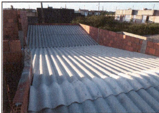
Execução do telhamento 05
