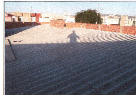
Execução do telhamento 03
