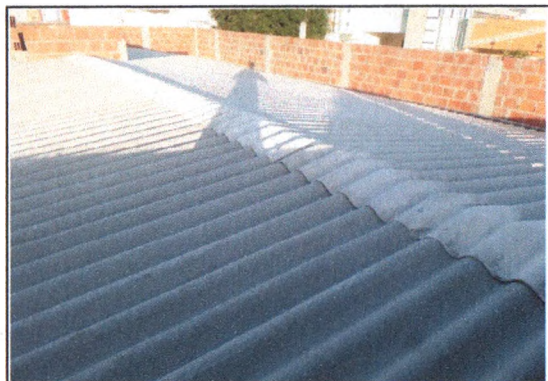
Execução do telhamento 01
