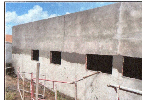
Execução do reboco 02
