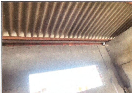
Instalação da calha 01
