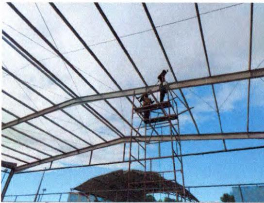
REMOÇÃO DE FERRUGEM; PINTURA DE ESTRUTURAS METÁLICAS
