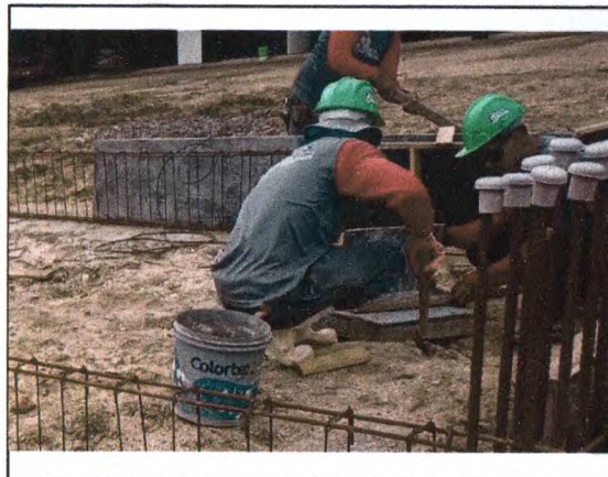
MONTAGEM DA FORMA E CONCRETAGEM DAS VIGAS BALDRAME
