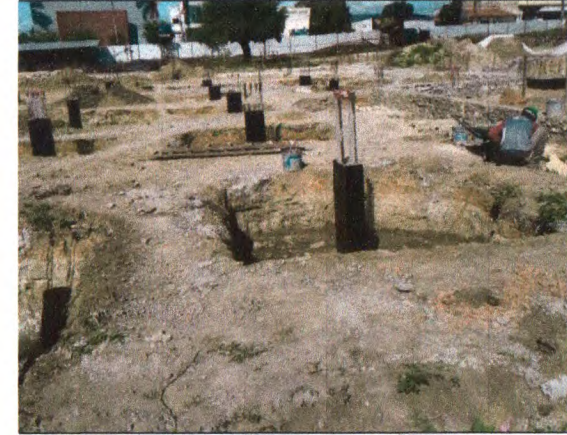
CONCRETAGEM E IMPERMEABILIZAÇÃO DOS PILARES DE ARRANQUE
