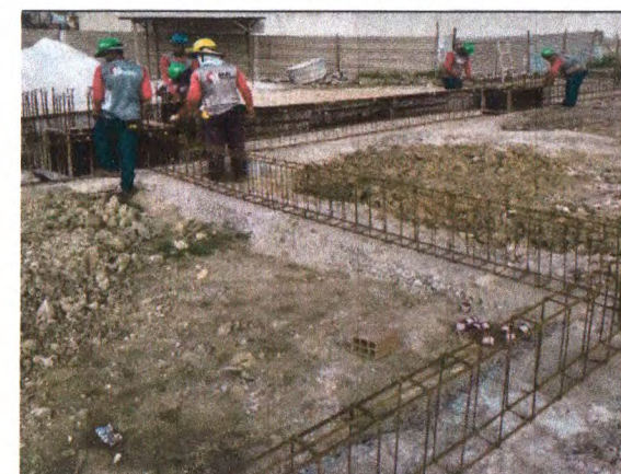
MONTAGEM DA FORMA PARA VIGA BALDRAME
