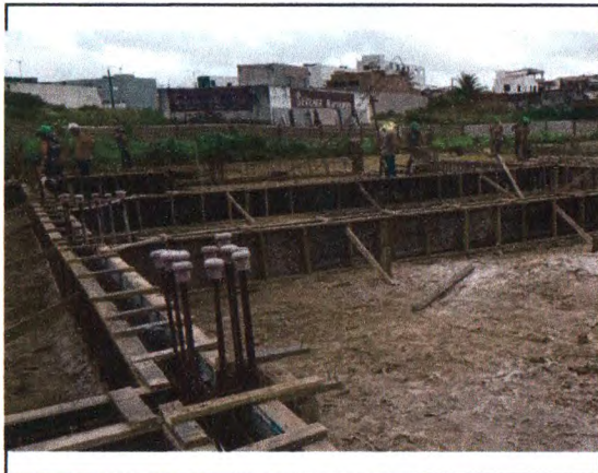
MONTAGEM DA FORMA PARA VIGA BALDRAME
