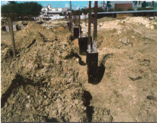
REATERRO SOBRE A FUNDAÇÃO
