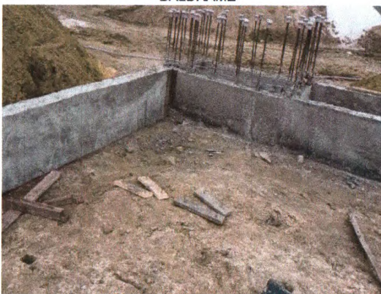
CONCRETAGEM DAS VIGAS BALDRAME
