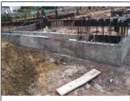
CONCRETAGEM DAS VIGAS BALDRAME
