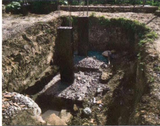
CONCRETAGEM E IMPERMEABILIZAÇÃO DOS PILARES DE ARRANQUE
