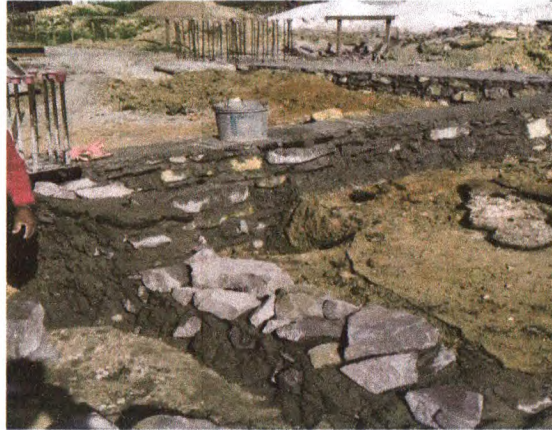
ESCAVAÇÃO E ALVENARIA DE PEDRA PARA VIGAS BALDRAME
