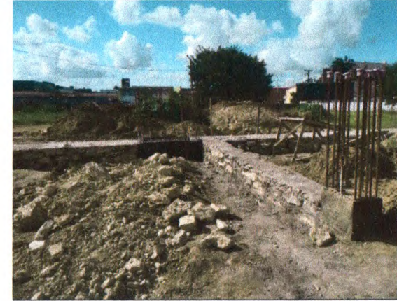
ESCAVAÇÃO E ALVENARIA DE PEDRA PARA VIGAS BALDRAME
