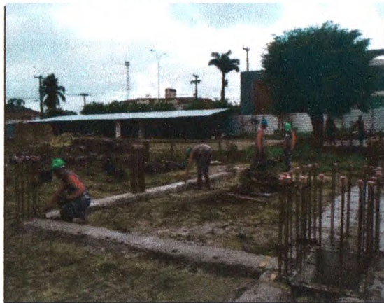
MONTAGEM DA FORMA PARA VIGA BALDRAME
