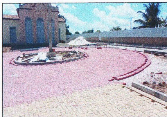
MEIO-FIO E PISO INTERTRAVADO
