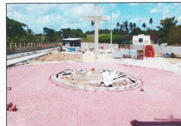
MEIO-FIO E PISO INTERTRAVADO
