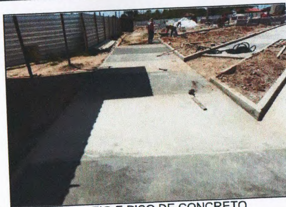
MEIO-FIO E PISO DE CONCRETO
