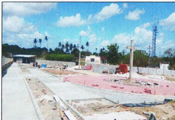
MEIO-FIO E PISO DE CONCRETO
