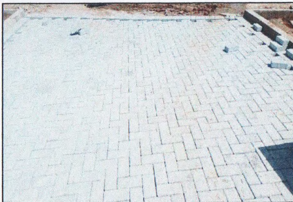
MEIO-FIO E PISO INTERTRAVADO
