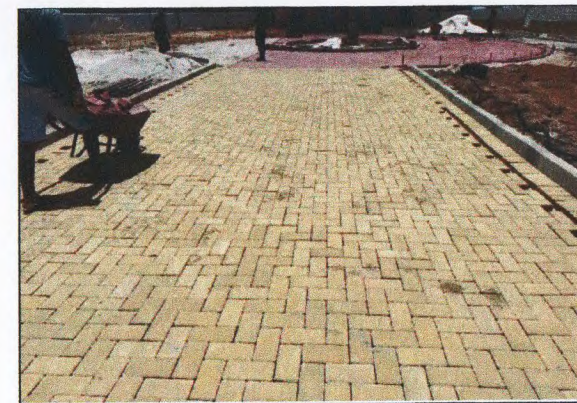
MEIO-FIO E PISO INTERTRAVADO
