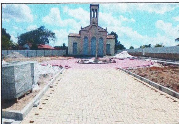
MEIO-FIO E PISO INTERTRAVADO
