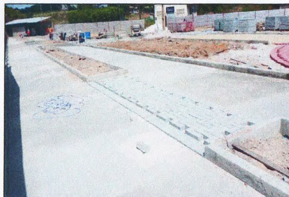
MEIO-FIO E PISO DE CONCRETO
