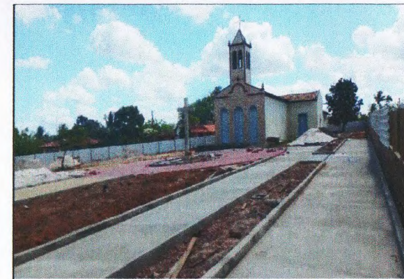
MEIO-FIO E PISO DE CONCRETO
