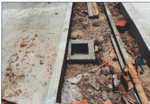
CAIXAS DE PASSAGENS
