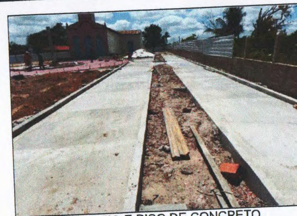
MEIO-FIO E PISO DE CONCRETO
