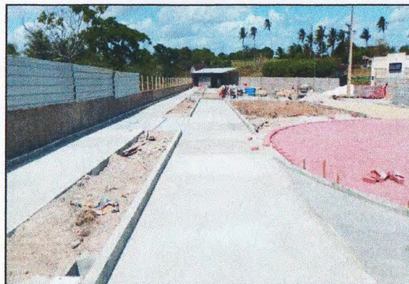
MEIO-FIO E PISO DE CONCRETO
