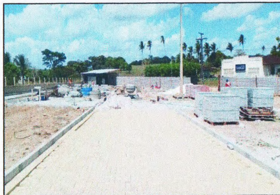
MEIO-FIO E PISO INTERTRAVADO
