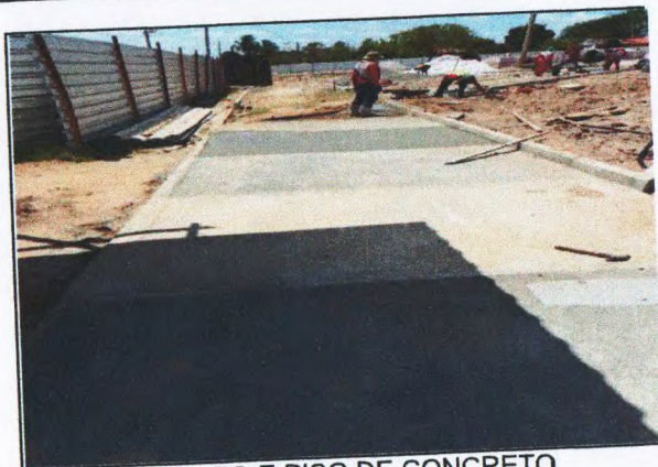
MEIO-FIO E PISO DE CONCRETO
