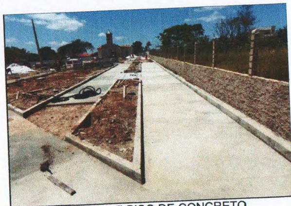
MEIO-FIO E PISO DE CONCRETO
