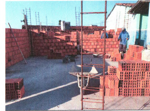
ALVENARIA DE BLOCO CERÂMICO; FERRAGEM DOS PILARES
