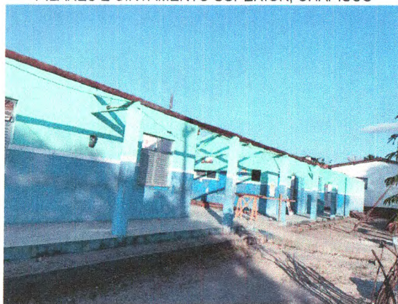
REFORMA - REVISÃO DA COBERTURA
