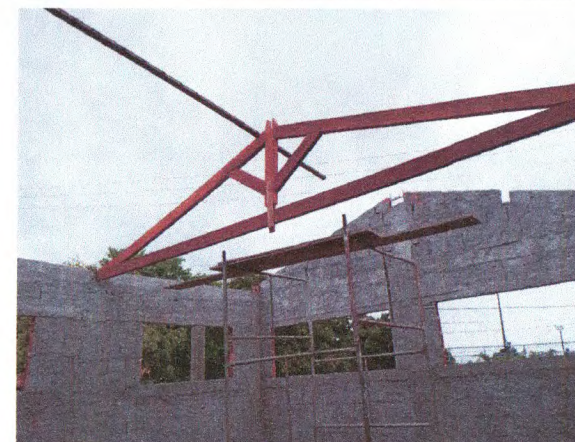
ALVENARIA DE BLOCO CERÂMICO; CHAPISCO; TESOURA EM MADEIRA
