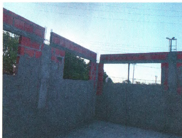
ALVENARIA DE BLOCO CERÂMICO; CONCRETO DOS PILARES E CINTAMENTO SUPERIOR; CHAPISCO
