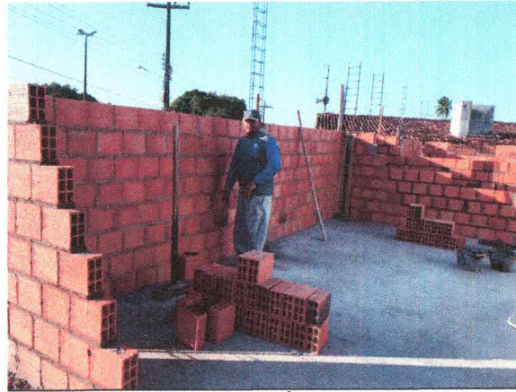
ALVENARIA DE BLOCO CERÂMICO; FERRAGEM DOS PILARES
