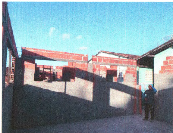
ALVENARIA DE BLOCO CERÂMICO; CONCRETO DOS PILARES E CINTAMENTO SUPERIOR; CHAPISCO
