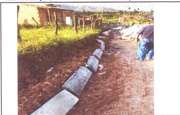
PAVIMENTAÇÃO EM PARALELEPÍEDO
