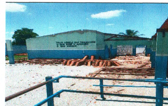
REMOÇÃO DE MADEIRAMENTO
