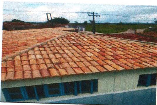
EMASSAMENTO DE CUMEEIRA
