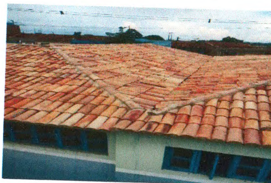
EMASSAMENTO DE CUMEEIRA
