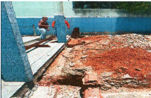
DEMOLIÇÃO DE PISO
