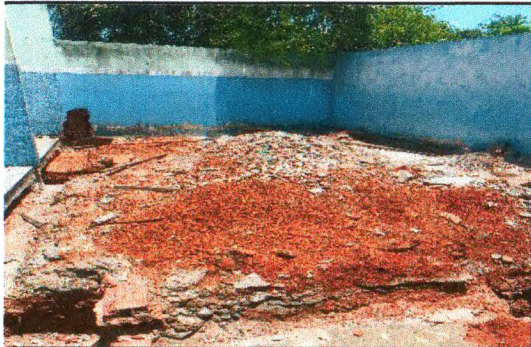
LOCAÇÃO DE OBRA
