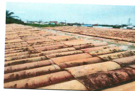
EMASSAMENTO DE CUMEEIRA
