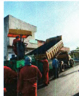
PAVIMENTAÇÃO ASFÁLTICA
