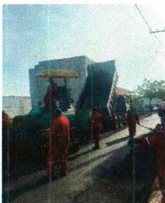
PAVIMENTAÇÃO ASFÁLTICA
