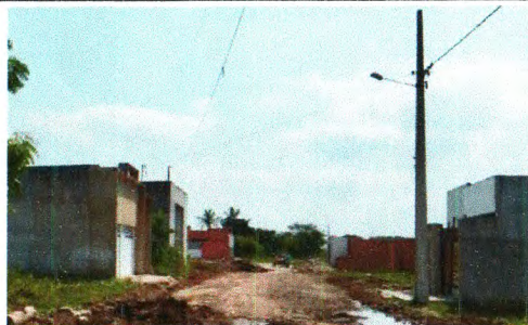
TERRAPLANAGEM, BASE E SUB-BASE
