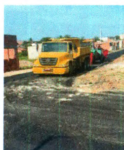
PINTURA DE LIGAÇÃO E IMPRIMAÇÃO
