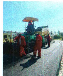
PAVIMENTAÇÃO ASFÁLTICA
