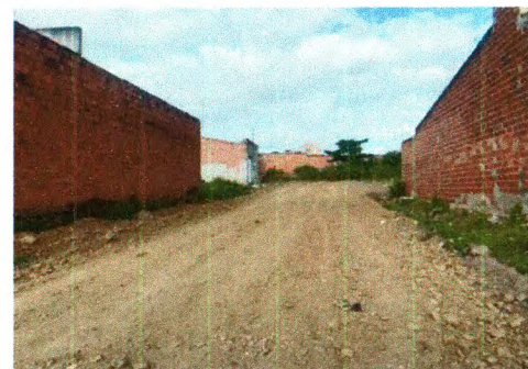
TERRAPLANAGEM, BASE E SUB-BASE
