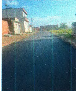
PAVIMENTAÇÃO ASFÁLTICA RUA ARNALDO SILVEIRA
