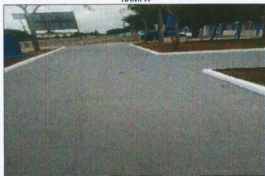
PINTURA DE PISO
