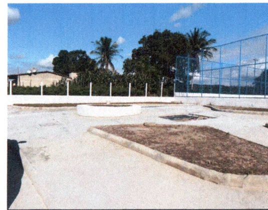
PISO EM CONCRETO E PINTURA SELADOR
