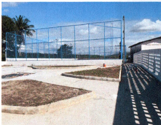
PISO EM CONCRETO E PINTURA SELADOR
