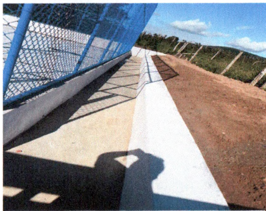
PISO EM CONCRETO E PINTURA SELADOR
