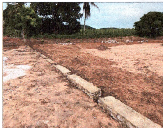
ALVENARIA DE PEDRA
