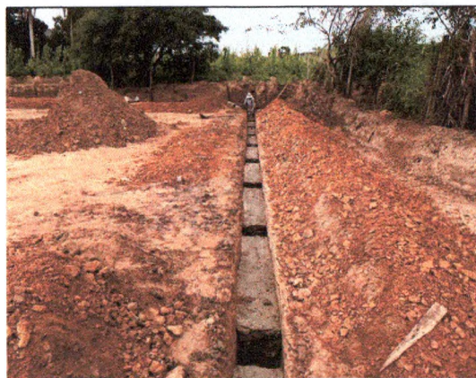
ALVENARIA DE PEDRA
