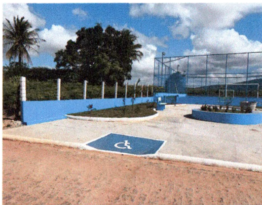
PINTURA E RAMPA DE DEFICIENTES
