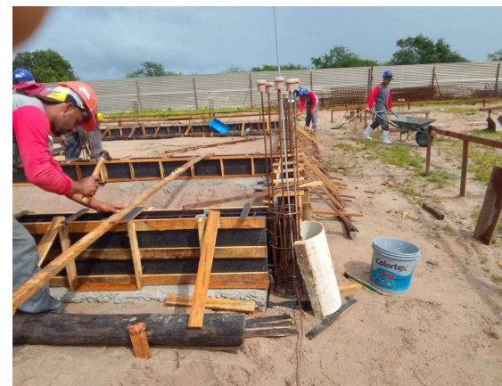
MONTAGEM DAS FORMAS PARA VIGAS BALDRAME DOS BLOCOS C E B
