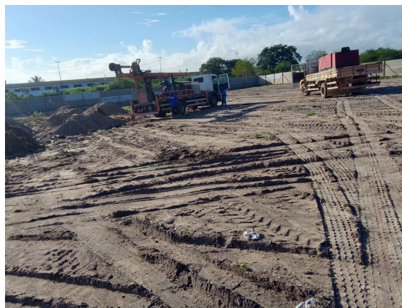
ESCAVAÇÃO PARA FUNDAÇÃO DO BLOCO C E DO BLOCO B
