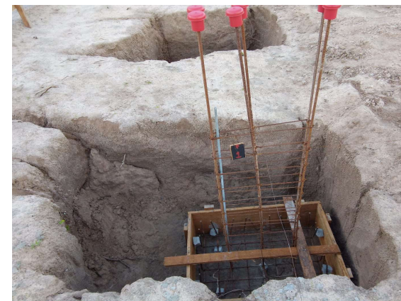
MONTAGEM DAS FORMAS DA BASE DAS SAPATAS COM AS FERRAGENS E SPDA
