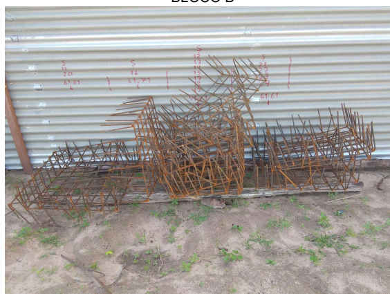
CORTE E DOBRA DAS FERRAGENS PARA A FUNDAÇÃO DAS EDIFICAÇÕES DO BLOCO C E DO BLOCO B
