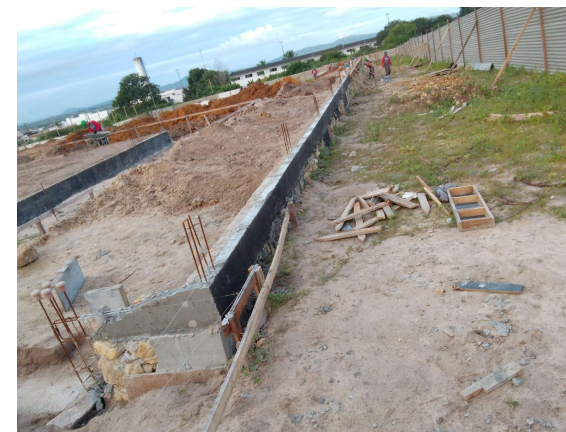
ALVENARIA DE PEDRA ARGAMASSADA; CINTAMENTO INFERIOR EM CONCRETO
