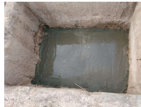
EXECUÇÃO DO CONCRETO MAGRO
