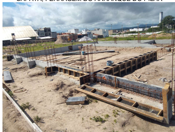
FERRAGEM; FORMA DE MADEIRA E CONCRETO DO VIGAMENTO INFERIOR DOS BLOCOS "B" E "C"
