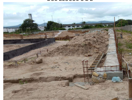
ESCAVAÇÃO E ASSENTAMENTO DA ALVENARIA DE PEDRA NO MURO LATERAL
