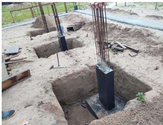
ESCAVAÇÃO; CONCRETO DAS SAPATAS E ARRANQUES DE PILARES E IMPERMEABILIZAÇÃO
