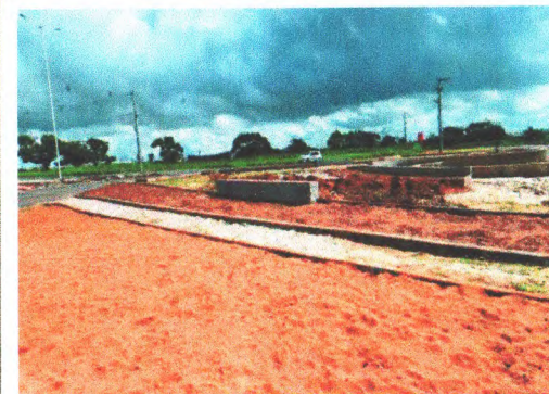
EXECUÇÃO DE ATERRO DA ROTATÓRIA 02
