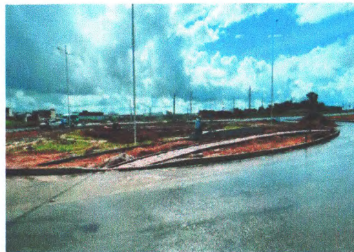
ESCAVAÇÃO, REGULARIZAÇÃO, COLCHÃO DE AREIA E MEIO-FIO DO CANTEIRO DA RÓTULA 03
