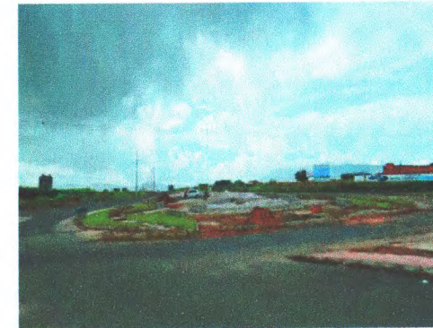
ESCAVAÇÃO, REGULARIZAÇÃO, COLCHÃO DE AREIA E MEIO-FIO DA ROTATÓRIA 01
