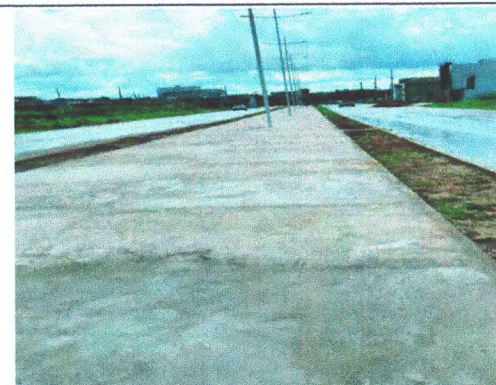
ATERRO E CONCRETO SIMPLES - CANTEIRO 04
