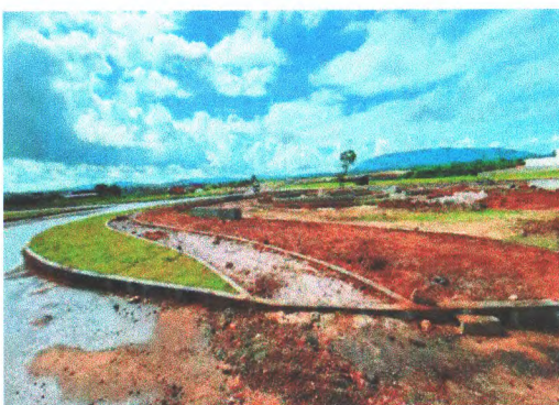
ESCAVAÇÃO, REGULARIZAÇÃO, COLCHÃO DE AREIA - ROTATÓRIA 02
