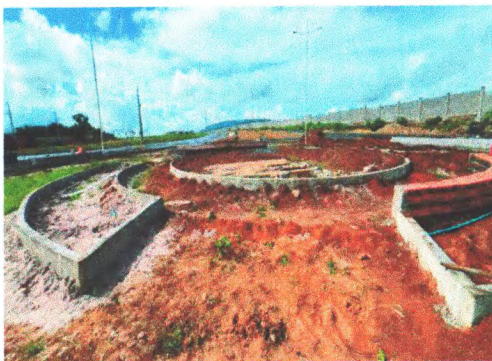
ESCAVAÇÃO, REGULARIZAÇÃO, COLCHÃO DE AREIA E MEIO-FIO DO CANTEIRO DA RÓTULA 03
