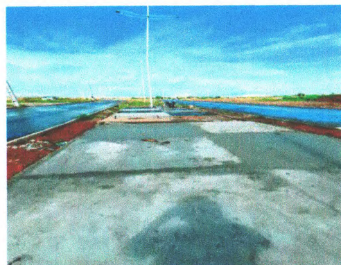
LIMPEZA, ESCAVAÇÃO, REGULARIZAÇÃO, COLCHÃO DE AREIA, MEIO-FIO, LONA PLÁSTICA E CONCRETO SIMPLES - CANTEIRO 04
