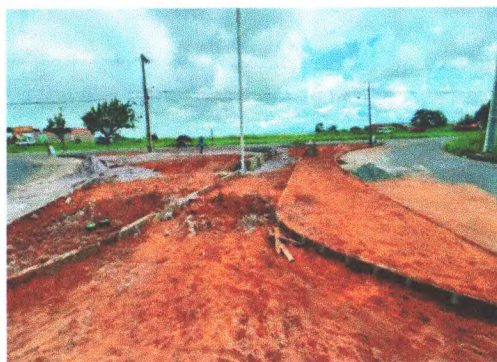
ESCAVAÇÃO, REGULARIZAÇÃO, COLCHÃO DE AREIA E MEIO-FIO DO CANTEIRO DO MARCO "JOÃO DE DEUS"
