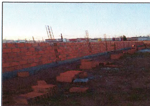
Construção do muro 02
