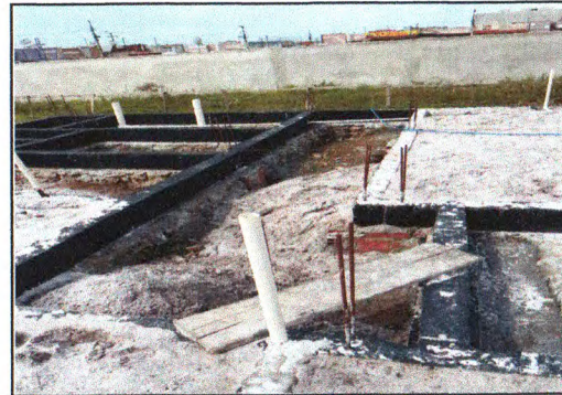
Fundação e impermeabilização 02
