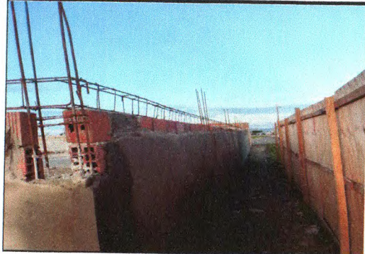
Construção do muro 10
