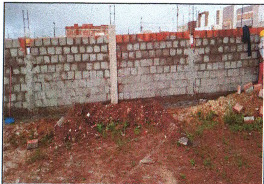
Construção do muro 04
