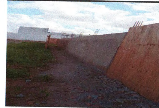
Construção do muro 12
