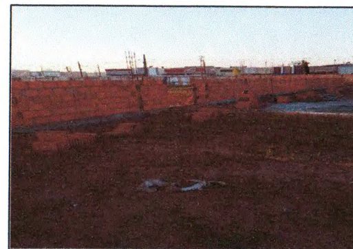
Construção do muro 03
