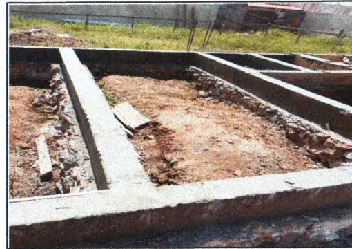
Concreto armado da fundação 02
