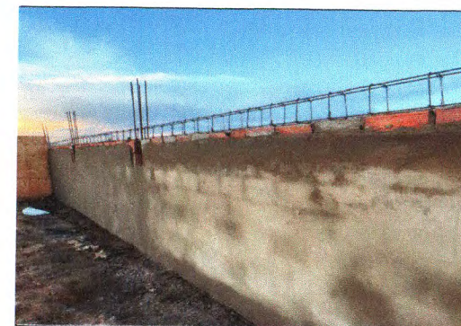
Construção do muro 09
