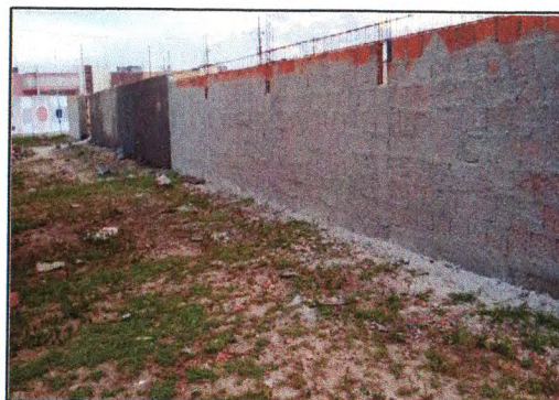
Construção do muro 08
