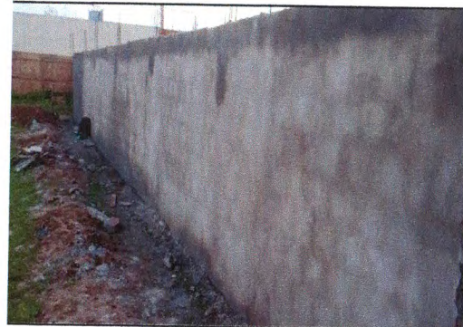
Construção do muro 14
