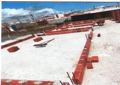
Alvenaria de bloco 01
