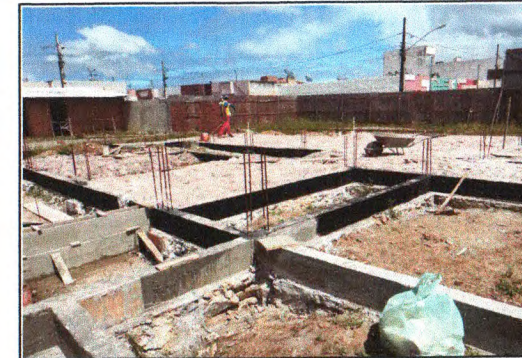
Concreto armado da fundação 03
