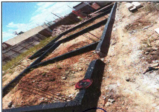
Fundação e impermeabilização 01
