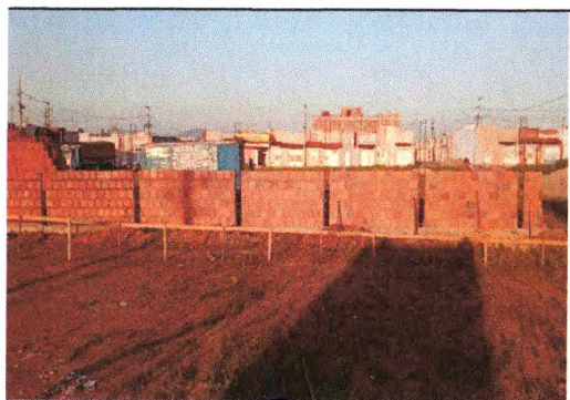
Construção do muro 01
