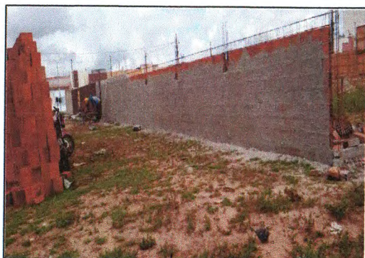
Construção do muro 07
