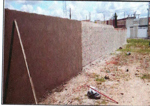
Construção do muro 11
