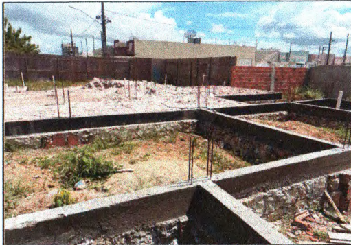
Concreto armado da fundação 01
