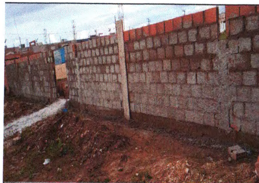
Construção do muro 05
