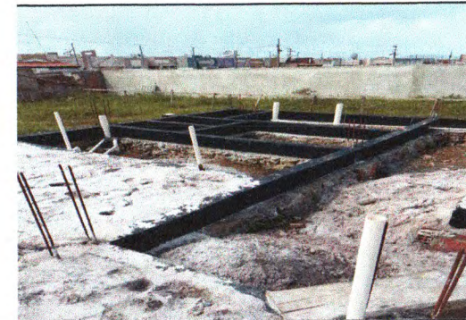
Fundação e impermeabilização 03
