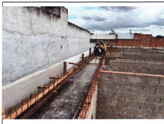
PREPARAÇÃO PARA LAJE MACIÇA
