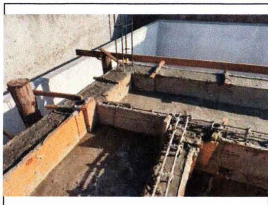
LAJE MACIÇA E VIGAS SUPERIORES
