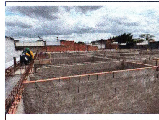
PREPARAÇÃO PARA LAJE MACIÇA E VIGAS SUPERIORES
