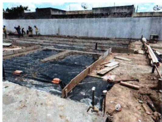
LONA PLÁSTICA E EXECUÇÃO DA CAMADA IMPERMEABILIZADORA
