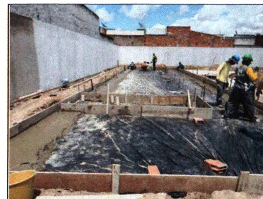
LONA PLÁSTICA E EXECUÇÃO DA CAMADA IMPERMEABILIZADORA
