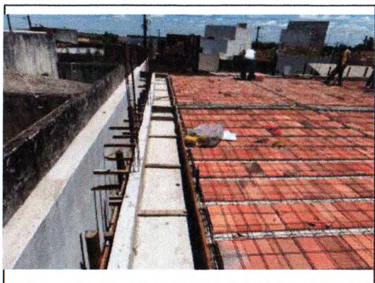
LAJE MACIÇA E VIGAS SUPERIORES
