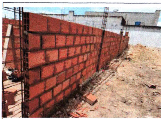
ELEVAÇÃO DE ALVENARIA
