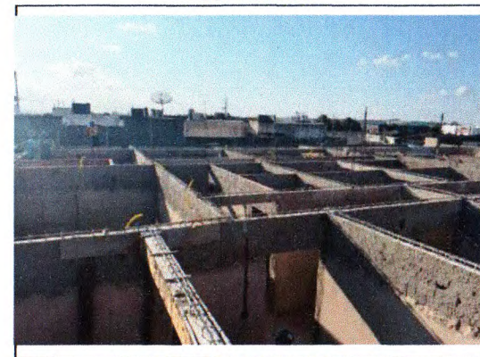
LAJE MACIÇA E VIGAS SUPERIORES
