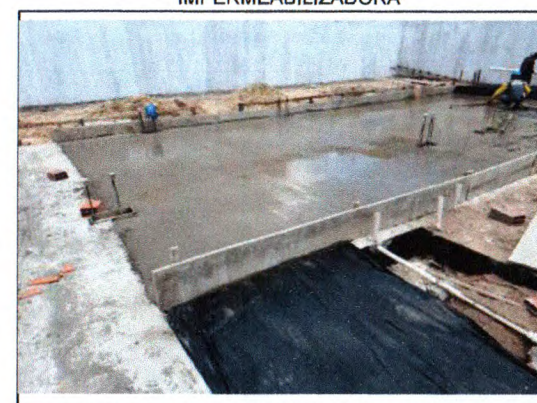
LONA PLÁSTICA E EXECUÇÃO DA CAMADA IMPERMEABILIZADORA
