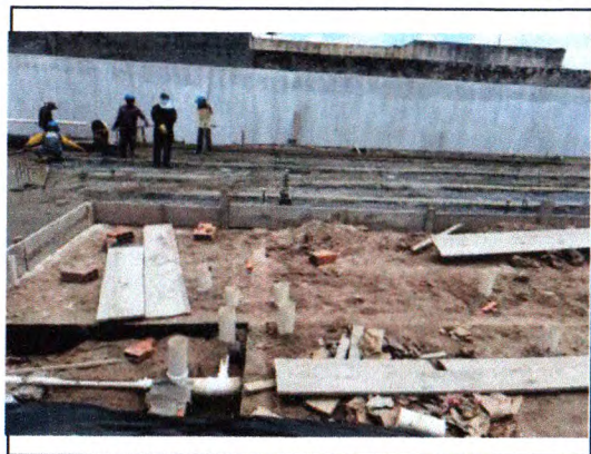
LONA PLÁSTICA E EXECUÇÃO DA CAMADA IMPERMEABILIZADORA
