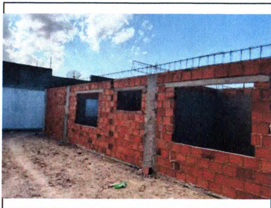
ELEVAÇÃO DE ALVENARIA, VIGAS E PLARES
