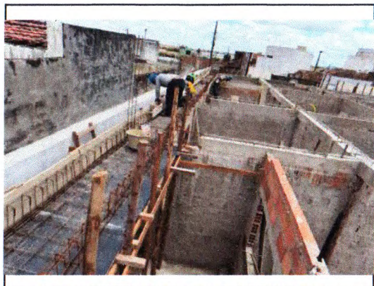
PREPARAÇÃO PARA LAJE MACIÇA
